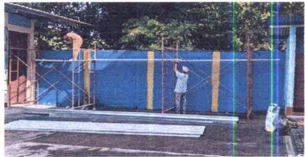
Foto 4: Suministro e instalación de block en muro perimetra. Repello de muro perimetral. Sustitución de banquetta de adoquín por losa de concreto.
