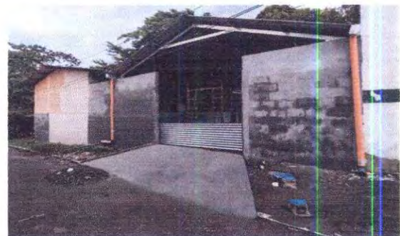
Foto 6: Sustitución de puerta de metal por portón de metal de 3.30 x 2.70 mts.
