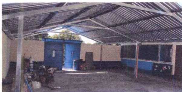
Foto 5: Reparación de losa de concreto de área recrearia de 9.10 x 14 mts. Suministro e instalación de lámina en área de patio. Suministro e instalación de estructura de soporte de metal en área de patio.
