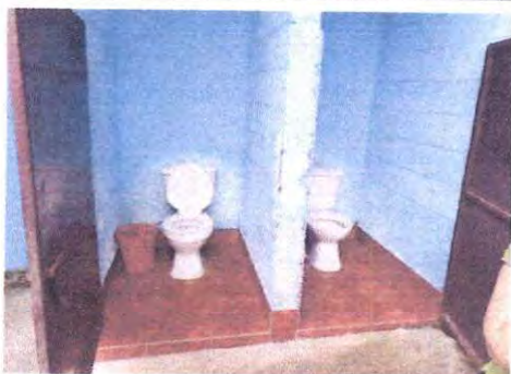
Foto1: Sustitución de accesorios inodoros.
