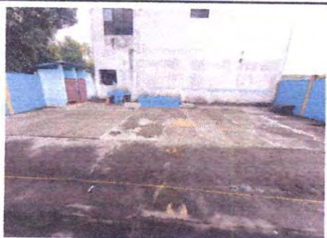
Foto 5: Reparación de losa de concreto de área recreativa de 9.10 x 14 mts. Suministro e instalación de lámina en área de patio. Suministro e instalación de estructura de soporte de metal en área de patio.
