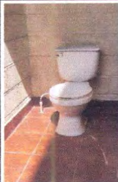
Foto 1: Sustrucción de accesorios inodoros.
