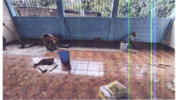
Foto 2: Sustitución de piso de cemento líquido por piso cerámico en aula. Suministro de ventanas de pvc blanco 1.36 x 2.30 mts. En aulas.
