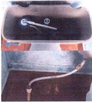
Foto1: Sustitución de accesorios inodoros.
