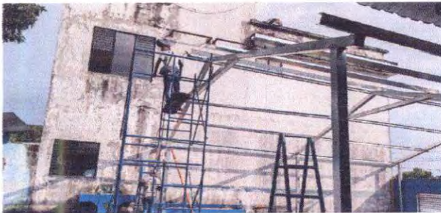
Foto 5: Reparación de losa de concreto de área recrearia de 9.10 x 14 mts. Suministro e instalación de lámina en área de patio. Suministro e instalación de estructura de soporte de metal en área de patio.
