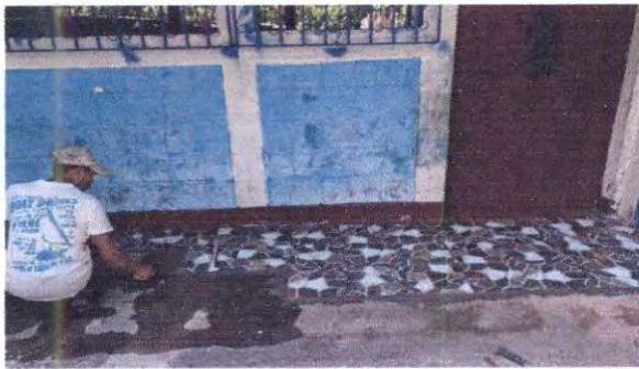
Foto 3: Sustitución de piso de torta de concreto por piso cerámico antideslizante en corredor. Pintura en muros exteriores e interiores.
