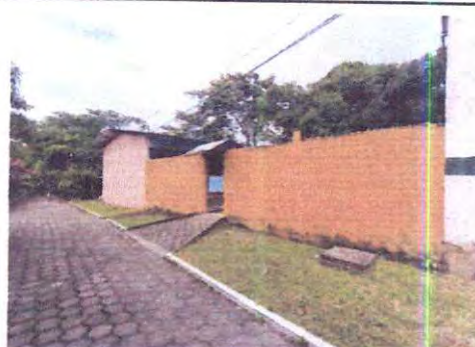
Foto 4: Suministro e instalación de block en muro perimetral. Repello de muro perimetral. Sustitución de banquetta de adoquín por losa de concreto.
