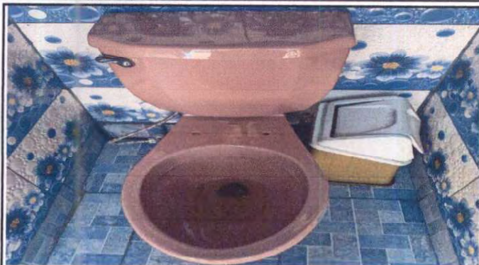
Foto7: Sustitución inodoro incluye accesorios
