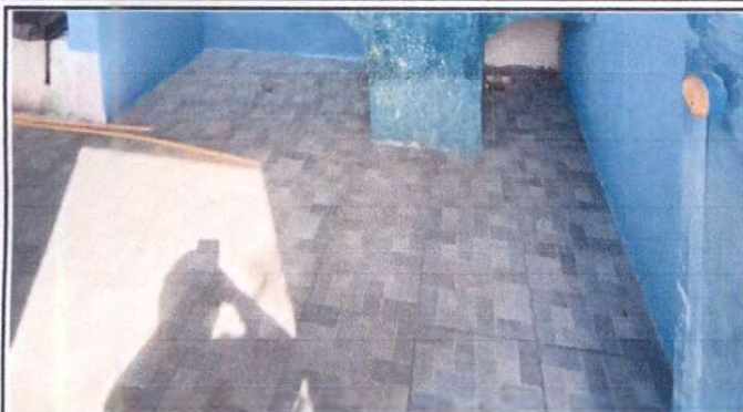
Foto1: Instalación piso cerámico antideslizante
