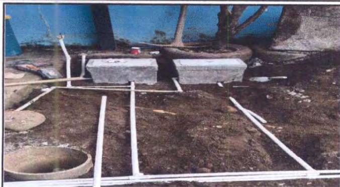
Foto 13: Sustitución de tubería PVC línea principal
