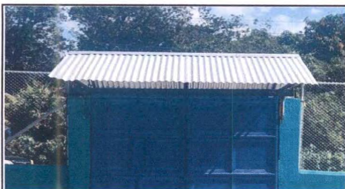
Foto 15: Sustitución de estructura de soporte de lámina, por lámina troquelada aluzinc calibre 26 en porton principal
