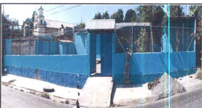
Foto 24: Pintura en muros exteriores del edificio escolar
