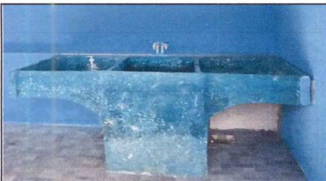
Foto 3: Sustitución de pila de concreto de 2 lavaderos
