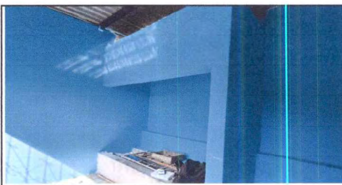
Foto 6: Pintura en muros interiores de cocina
