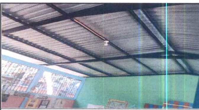
Foto 18: Sustitución de estructura de soporte de madera, por metal en aula
