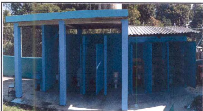
Foto 9: Pintura interior y exterior en sanitarios
