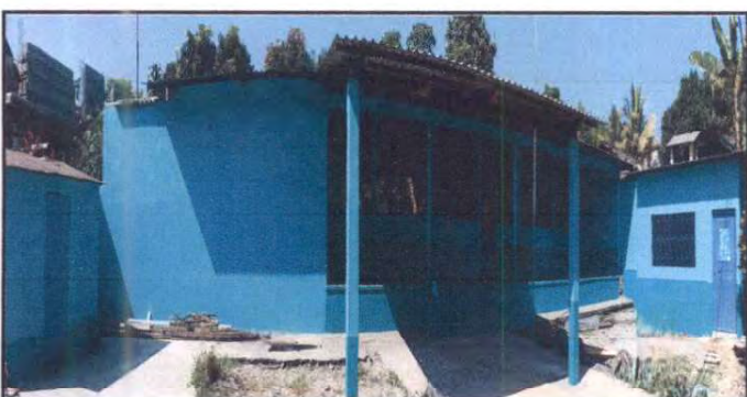
Foto 23: Pintura en muros exteriores del edificio escolar
