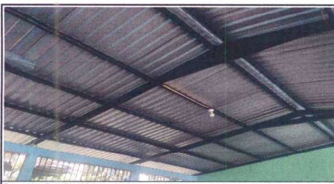
Foto 17: Sustitución de cubierta de lámina, por lámina troquelada aluzinc calibre 26
