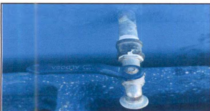
Foto 11: Sustitución de llave de chorro
