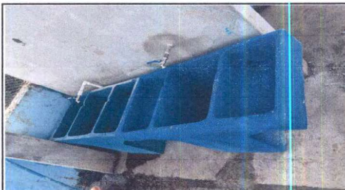
Foto 10: Instalación y Sustrucción de pila Baby de concreto de 2 lavaderos con drenaje
