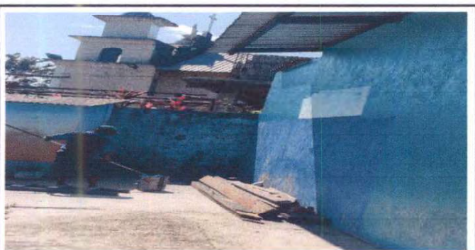
Foto 23: Pintura en muros exteriores del edificio escolar
