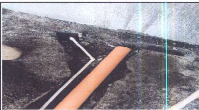
Foto 4: Sustitución de tubería PVC aguas negras
