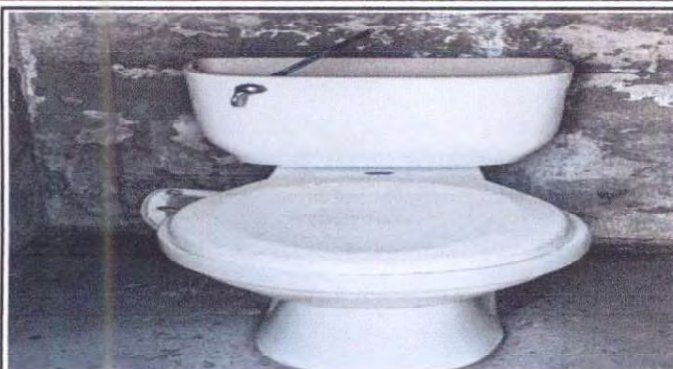
Foto7: Sustrucción inodoro incluye accesorios
