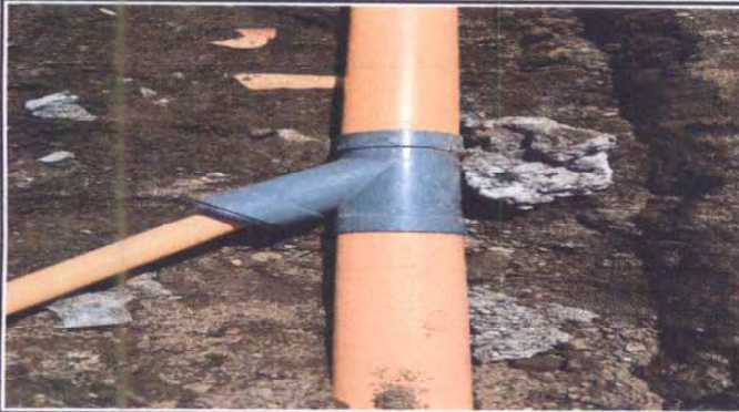
Foto 13: Sustrucción de tubería PVC línea principal
