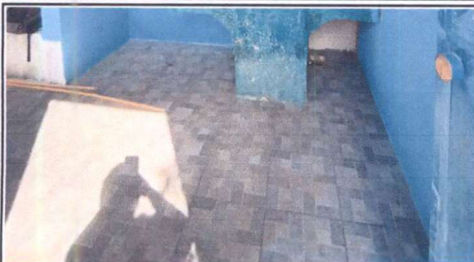
Foto1: Instalación piso cerámico antideslizante
