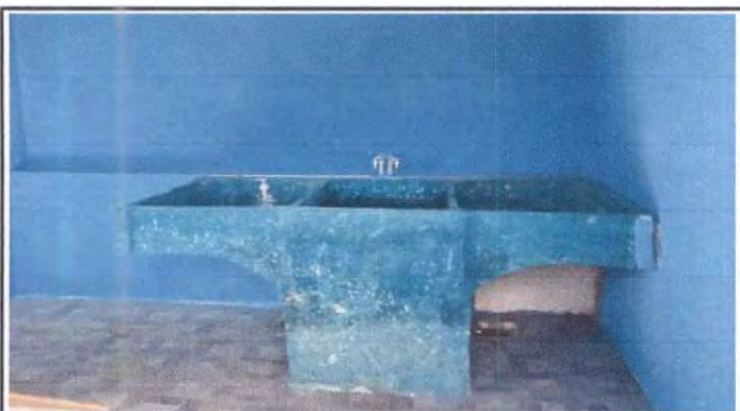
Foto 3: Sustitución de pila de concreto de 2 lavaderos
