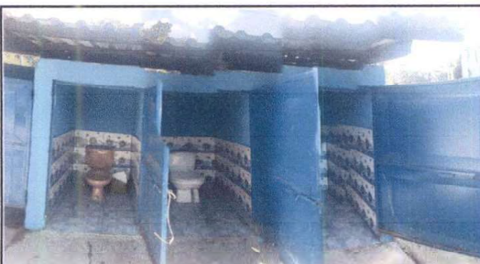
Foto 9: Pintura interior y exterior en sanitarios
