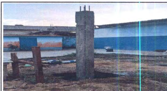
Foto 22: Instalación de Galera en patio
