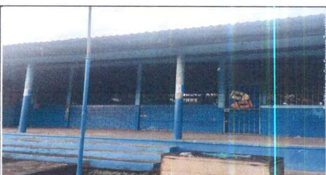
Foto 24: Pintura en muros exteriores del edificio escolar
