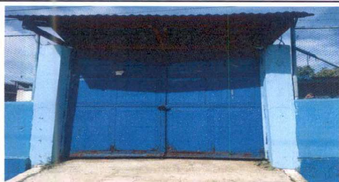
Foto 13: Mantenimiento portón principal de metal de 3.00 x 3.50
