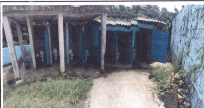
Foto 9: Pintura interior y exterior en sanitarios
