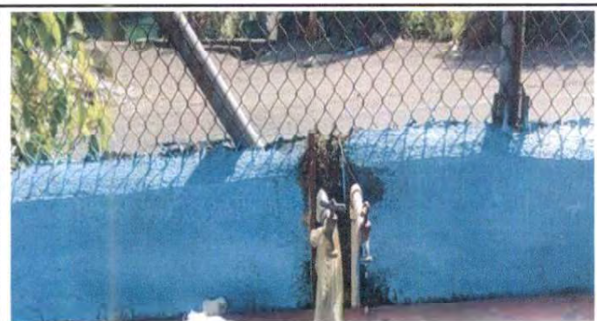
Foto 11: Sustitución de llave de chorro
