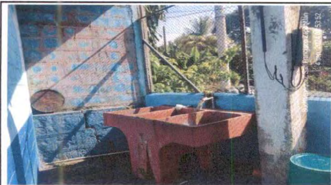
Foto 3: Sustitución de pila de concreto de 2 lavaderos
