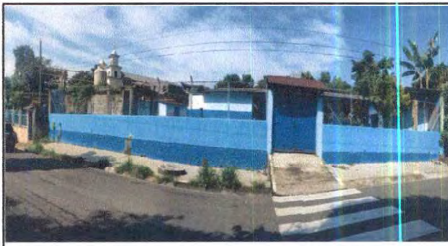
Foto 18: Reparación de muro perimetral de block con tubo hg y malla galvanizada, soleras intermedias y columnas.
