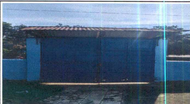
Foto 14: Sustitución de estructura de soporte de lámina, por lámina troquelada aluzinc calibre 26 en porton principal
