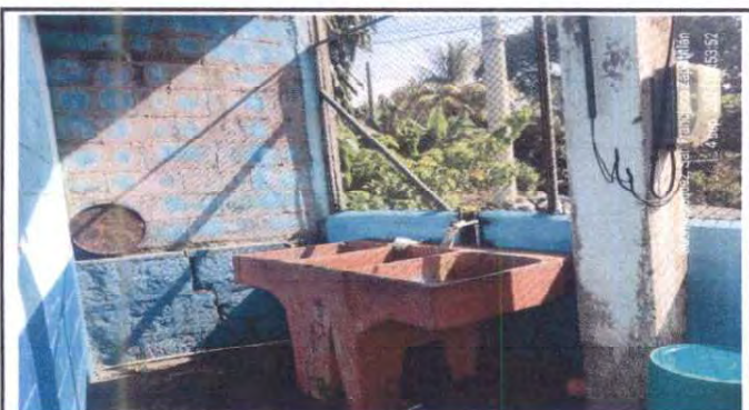
Foto 3: Sustitución de pila de concreto de 2 lavaderos
