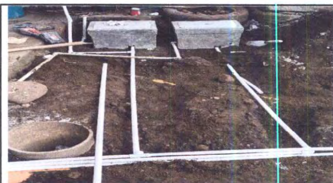
Foto 4: Sustitución de tubería PVC aguas negras
