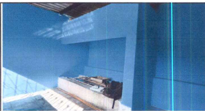
Foto 6: Pintura en muros interiores de cocina
