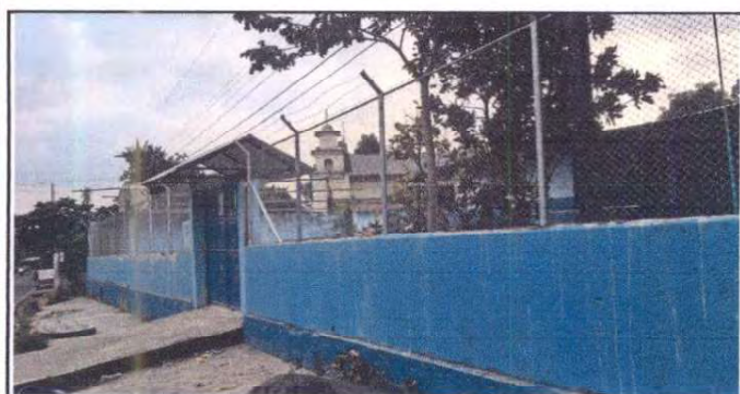
Foto 23: Pintura en muros exteriores del edificio escolar
