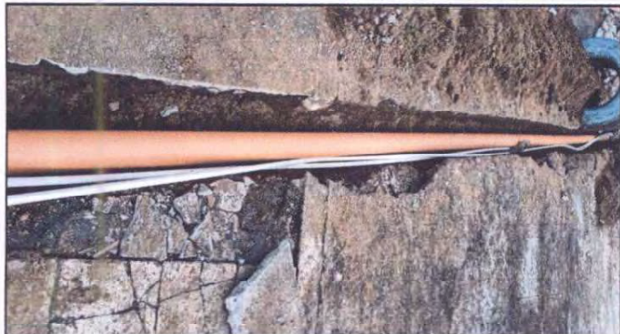
Foto 13: Sustrucción de tubería PVC línea principal
