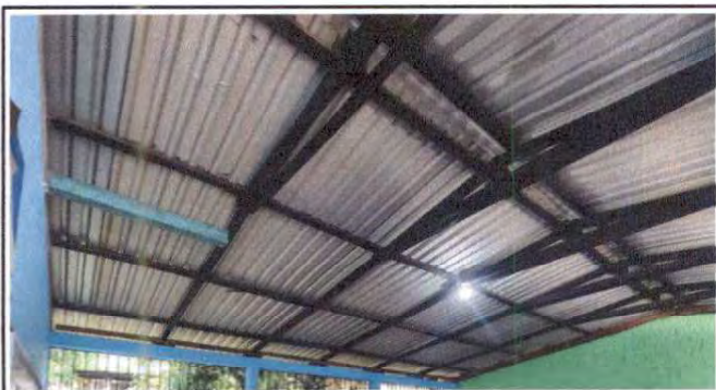
Foto 17: Sustitución de lámina, por lámina troquelada aluzinc calibre 26
