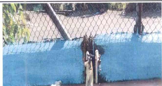
Foto 11: Sustitución de llave de chorro
