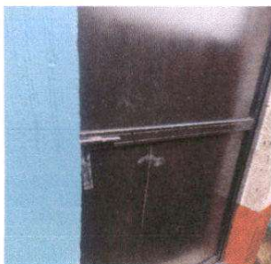
Foto 5: Sustitución puerta de aula informal lado izquierdo
