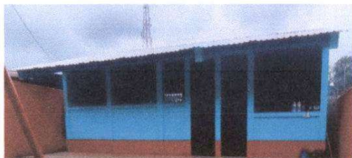
Foto1: Sustitución de lámina y mantenimiento a estructura de sostenimiento de techo
