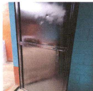
Foto 4: Sustitución de puerta de baño
