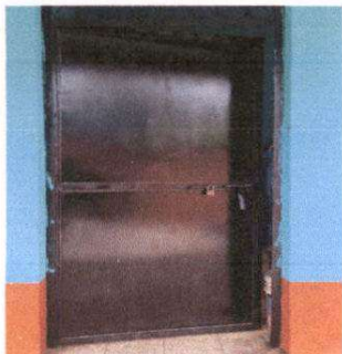
Foto 3: Sustitución de puerta aula pequeña informal
