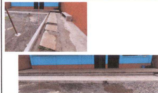
Foto 12: Losa de patio (plancha de concreto)
