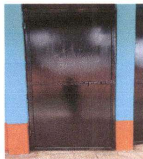
Foto 2: Sustitución puerta aula grande formal
