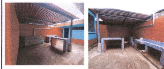
Foto 11: instalación de estructura de metal e instalación de lamina y polleton
