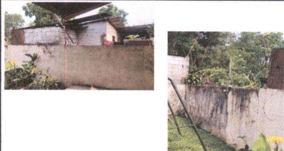
Foto 10: pintura en muros exteriores
