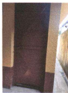
Foto 4: Sustrucción de puerta de baño
