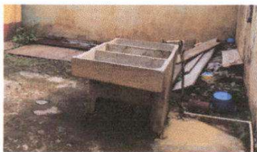
Foto 9: Sustitución de pila de cemento de un lavadero
