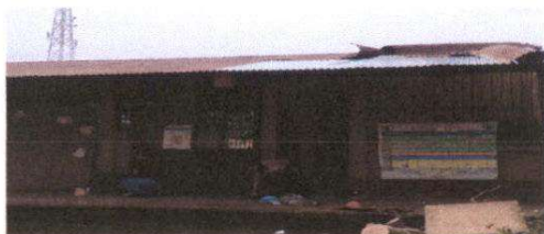
FOTO 1: Sustrucción y mantenimiento a estructura de sostenimiento de techo
