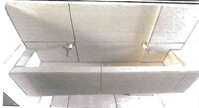
Foto 20: Mejoramiento en lavamanos en sanitarios y azulejo.
