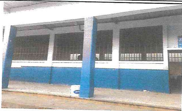
Foto 19: Sustitución de ventanas con marco de madera y sedazo, por marcos de metal con malla mino en 3 aulas.
