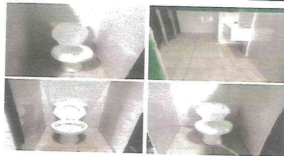
Foto 24: Sustitución de 3 sanitarios en el área de sanitarios y colocación de azulejo.
