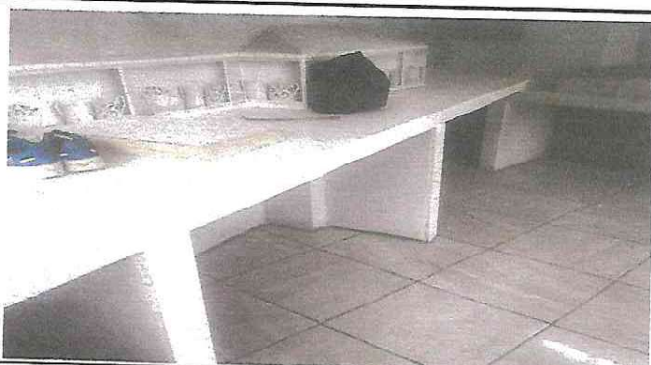
Foto 21: Sustitución y mejoramiento en mueble de cocina de concreto con azulejo.
