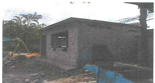
Foto 15: Sustitucion de techo por lamina troquelada calibre 26.
