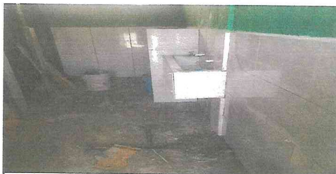
Foto 18: Sustitucion de azulejo en paredes de sanitario.
