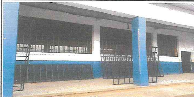
Foto 14: Sustitucion de balcones de madera con sedazo por balcones de metal con malla mini.
