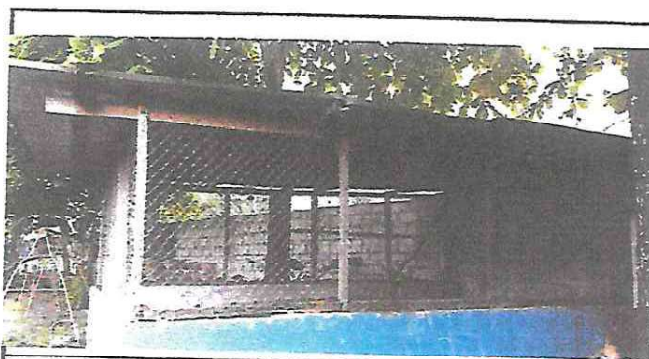
Foto 6: Sustitución de Estructura de Soporte de madera, por metal y sustitución de lamina, por lamina troquelada calibre 26.
