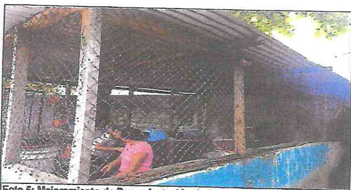
Foto 5: Mejoramiento de Pare e Instación de Balcones.
