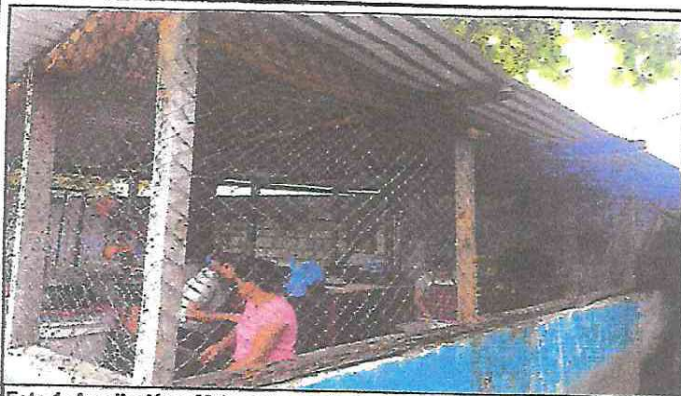
Foto 1: Ampliación y Mejoramiento de Cocina
