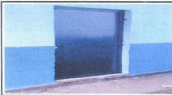
Foto 5: Instalación de puertas de metal 1.00 x 2.00 mts
