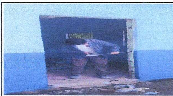
Foto 5: Instalación de puertas de metal 1.00 x 2.00 mts
