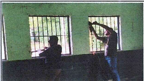
Foto 3: Mantenimiento a balcones de metal 0.60 X 1.00 mts
