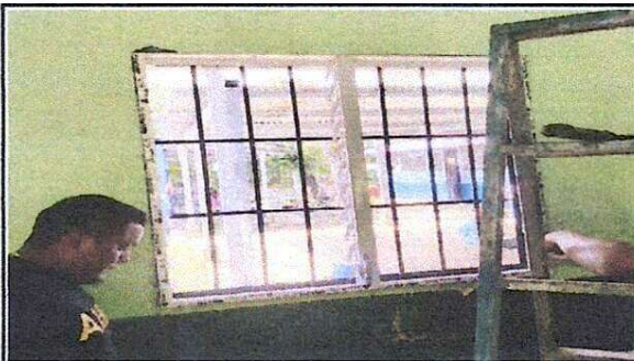
Foto 4: Instalacion de ventanas de aluminio, tipo persiana con vidrio nevado 0.60 x 1.00 mts
