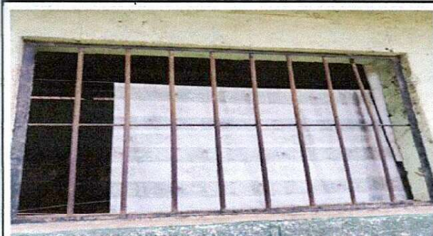
Foto 3: Mantenimiento a balcones de metal 0.60 X 1.00 mts
