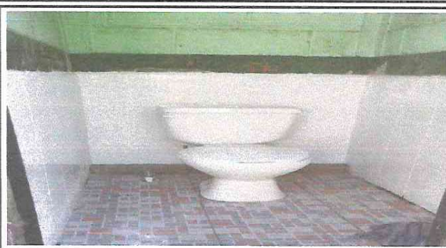
Foto 2. Instalación de piso Cerámico y azulejo en sanitarios. En Croquis 2
