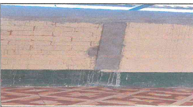
Foto 6. Reparación de grietas en aula. En Croquis 6
