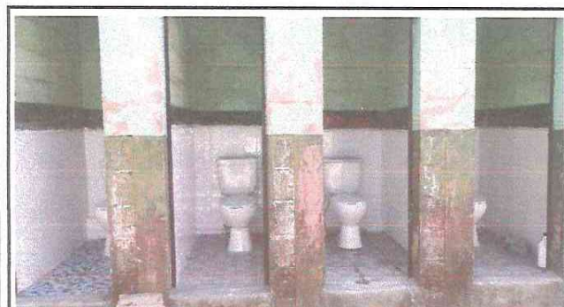
Foto 3. Instalación de sanitarios. En croquis 3
