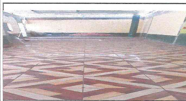
Foto 5. Instalación de piso cerámico en aulas. En croquis 5
