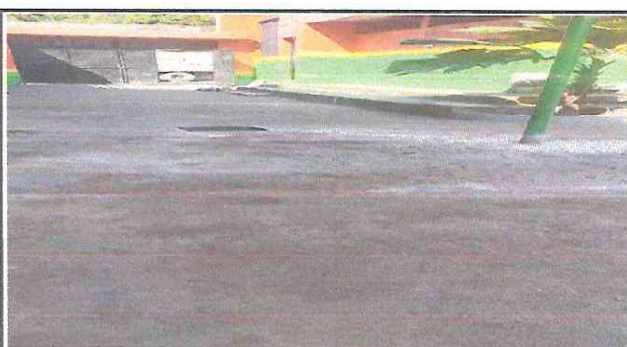
Foto 4. Reparación de torta de piso en patio. En croquis 4
