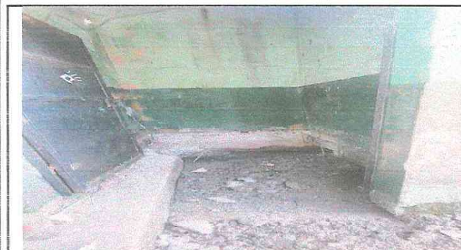
Foto 3: Reparación de Sanitarios
