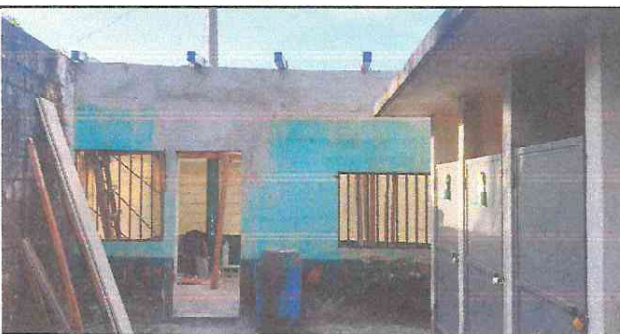
Foto 5. Sustitución de Lámina por lámina troquelada calibre 26 y Sustitución de estructura de soporte de madera, por metal.
