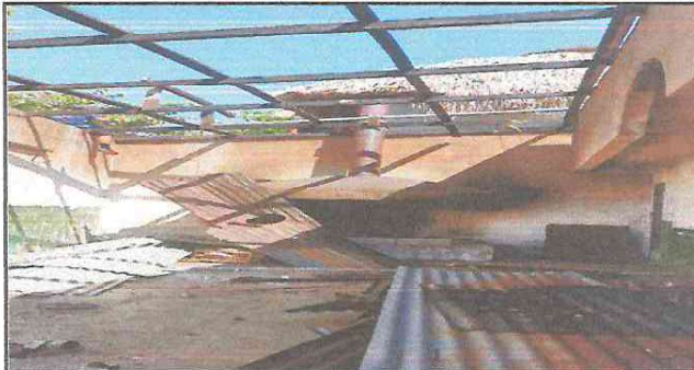
Foto 2. Desmantelación de lámina en cocina. Croquis 2
