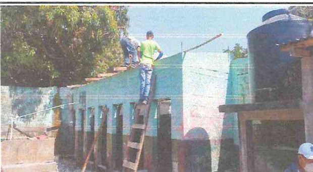
Foto 3. Desmantelación de lámina de sanitarios. Croquis 3
