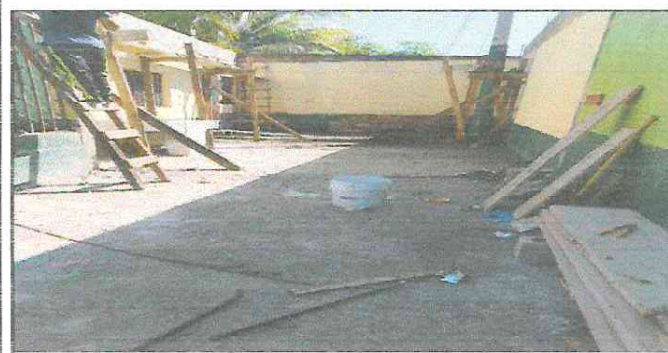
Foto 5: levantamiento de tres hiladas de block en dos aulas
