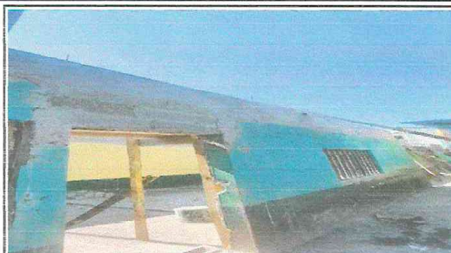
Foto 2: Reparación de Grieta en pared
