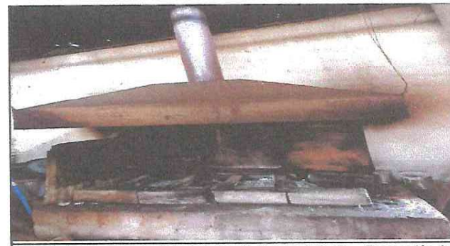
Foto 12. Mantenimiento de Estufa Rural. Ver croquis 12. Reparación de chimenea, Ver croquis 12. Sustitución de muebles de cocina. Ver croquis 13.
