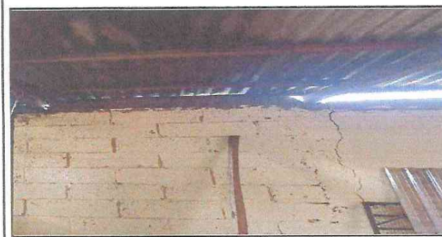
Foto 11. Reparación de pared de Block. Ver croquis 11
