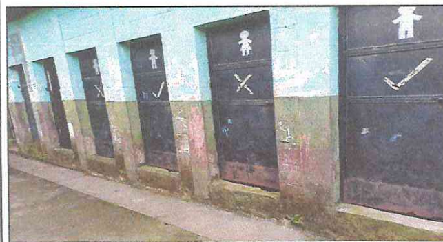
Foto 9. Pintura en muros exteriores e interiores. Ver croquis 9 Mantenimiento a estructura ( lijado, sujeciones, aplicación de pintura)
