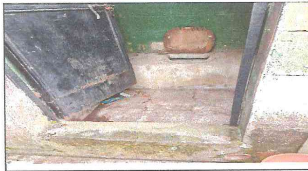
Foto 10. Sustitución de Inodoro ver croquis 10. Sustitución de tubería PVC línea principal aguas negras. Ver 10.5
