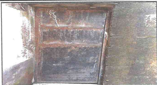
Foto 7. Mantenimiento de estructura ( lijado, aplicación de pintura, Sujeciones) en croquis 7
