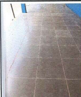
Foto 1: Sustrucción de piso cerámico
