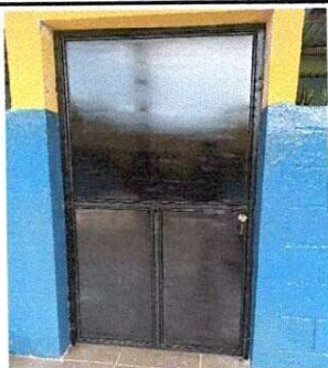
Foto 3: cambio de puertas
