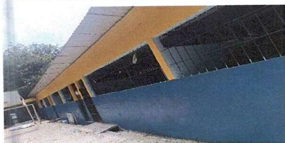
Foto 5: Pintura exterior e interior
