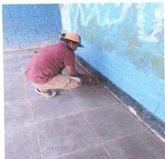
Foto 3: Sustitución de piso
