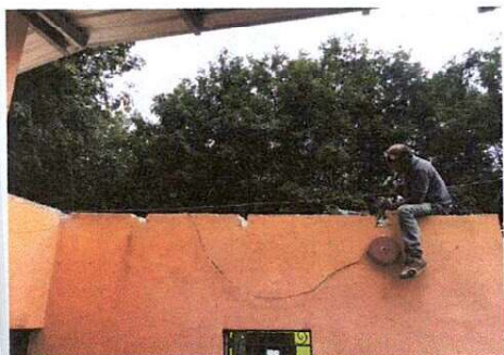
Foto1: Cambio de techo
