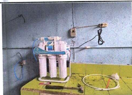
Foto 5: Instalación de filtro
