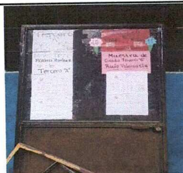
Foto 6: Cambio de puertas
