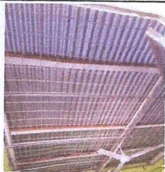
FOTO 1: Sustitución de lámina troquelada cal,26
