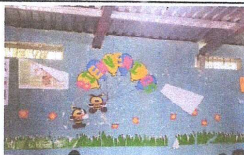
Foto 4: Aplicación de Pintura
