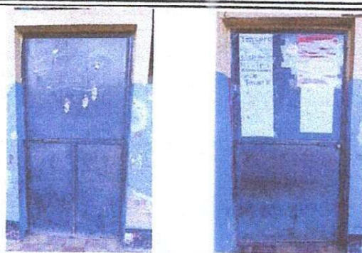
FOTO 2: Sustitución de puertas
