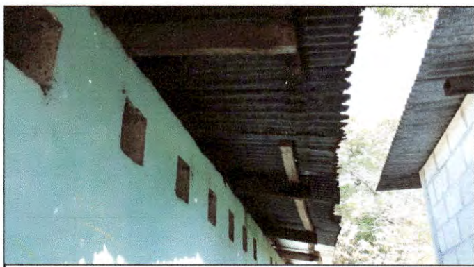
Foto 11: Se solicita el suministro e instalación de canales y bajadas de agua pluvial, ya que no se cuenta con estos canales en ningún módulo de la escuela.
