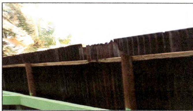
Foto 12: Debido a que el establecimiento no cuenta con canales y bajadas de agua pluvial, se solicita el suministro e instalación de estos mismos.
