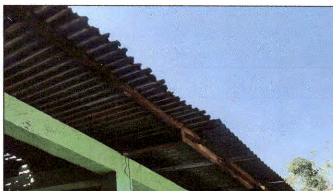
Foto 10: Se solicita el suministro e instalación de canales y bajadas de agua pluvial, ya que no se cuenta con estos canales en ningún módulo de la escuela.
