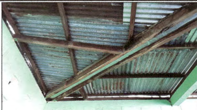
Foto 7: Estado actual de la estructura de madera, solicitan el cambio de esta misma por una estructura metálica.
