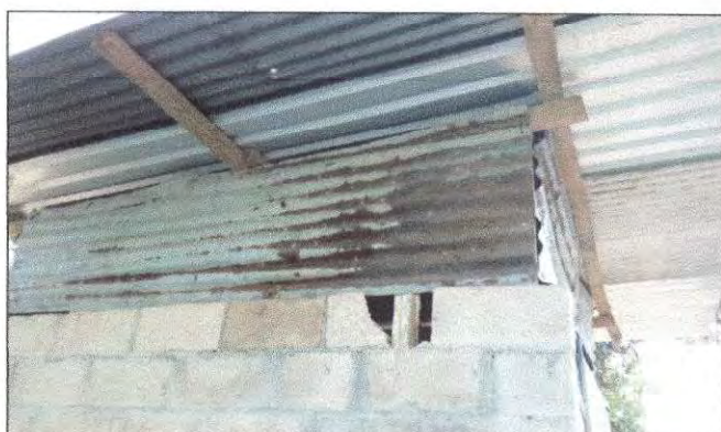
Foto 10: Debido a los problemas serios con relación a la seguridad, se solicita la finalización de muro en cocina.
