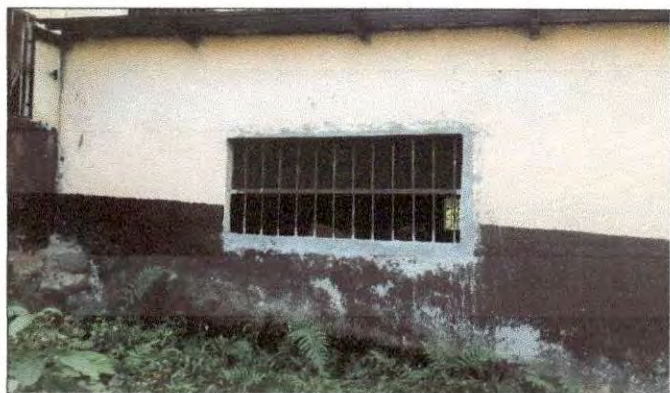
Foto 9: Estado actual de la pintura de los muros del establecimiento, solicitan la aplicación de pintura ya que la que se encuentra actualmente está desgastada.
