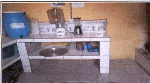
Foto 1: Instalación de gabinete de concreto armado
