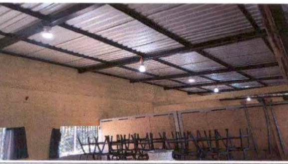
Foto 11: Sustrucción de ducto eléctrico más cableado y accesorios.
