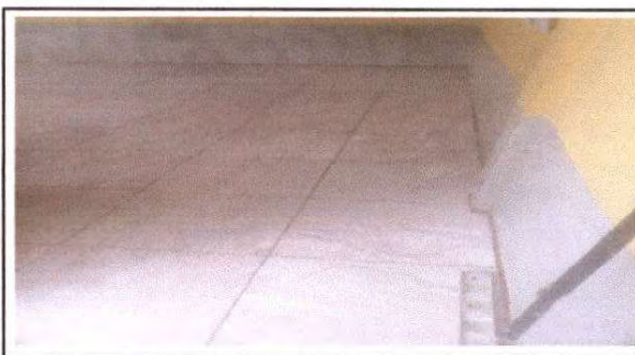
Foto 6: Reparación piso cerámico en aula.
