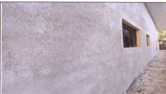
Foto 10: Repello en muro exterior trasero en aula módulo 2
