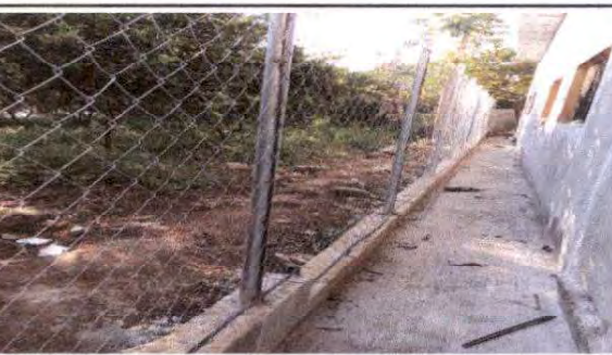
Foto 13: Sustitución de alambre espigado y postes de madera por tubo Hg y malla galvanizada.
