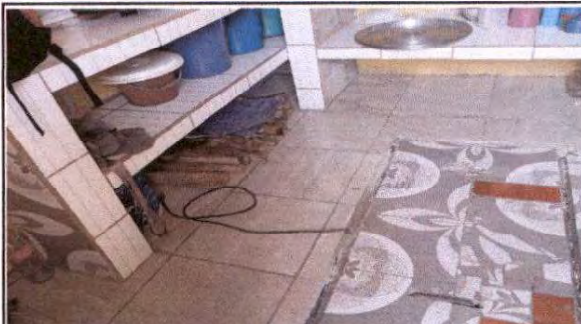
Foto 2: Sustitución de piso cerámico
