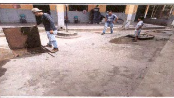
Foto 12: Limpieza de fosa séptica dimensiones según plano 3.5 x 3.5 x 2.6= 31.85 m3 incluye extracción y disposición adecuada en lodo
