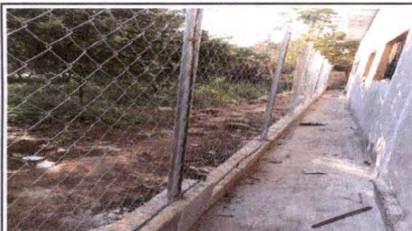
Foto 13: Sustitución de alambre espigado y postes de madera por tubo Hg y malla galvanizada.
