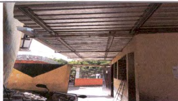
Foto 7: Sustrucción de lamina, por lamina troquelada calibre 26 de 7 pies.
