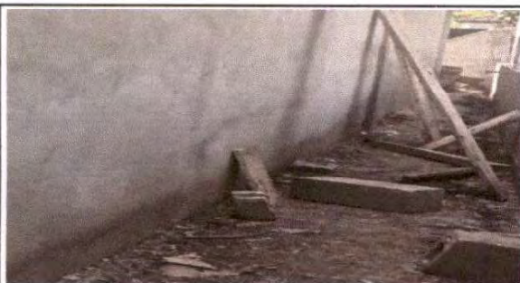
Foto 5: instalación de piso de torta de cemento exterior trasero aula módulo 1
