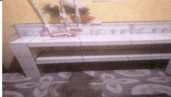
Foto 2: Sustitución piso cerámico
