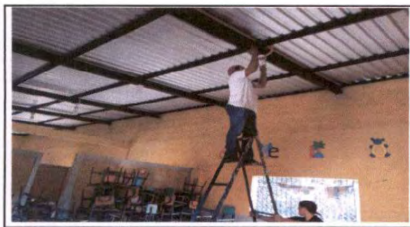
Foto 11: Sustrucción de ducto eléctrico más cableado y accesorios.
