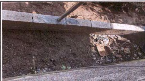
Foto 8: Instalación de piso de torta de cemento exterior trasero aula módulo 2
