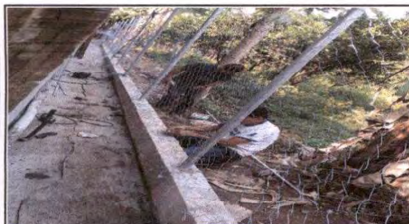
Foto 13: Sustitución de alambre espinado y postes de madera por tubo Hg y malla galvanizada.
