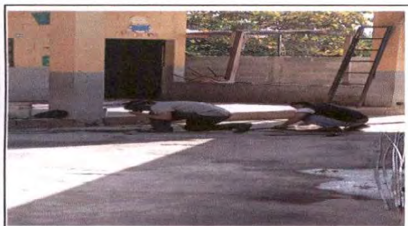
Foto 9: Instalación de vicerías de lámina arquitecta en ventana de 2.40 metros.
