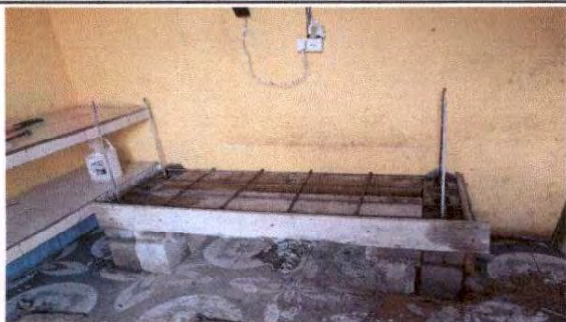
Foto 1: Instalación de gabinete de concreto armado
