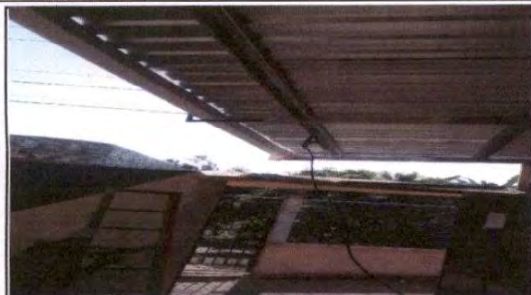
Foto 7: Sustrucción de lámina, por lámina troquelada calibre 26 de 7 pies.
