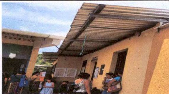
Foto 7: Sustitución de lámina, por lamina troquelada calibre 26 de 7 pies
