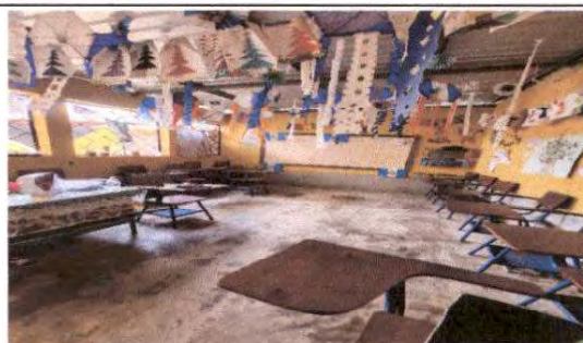
Foto 6: Reparación piso cerámico en aula
