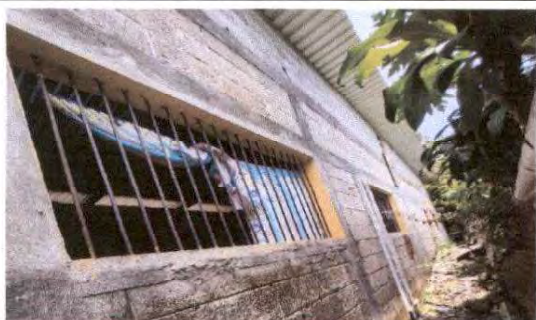
Foto 9: Instalación de viceras de lámina arquiteja en ventana de 2.40 metros
