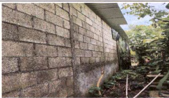
Foto 4: Repello en muro exterior trasero
