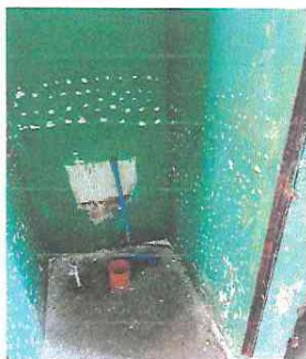
sustitución de azulejo y red de drenaje
