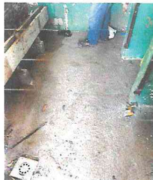
mantenimiento de los servicios sanitarios
