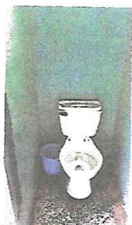
sustitución de sanitarios e implementación de azulejos en las paredes.
