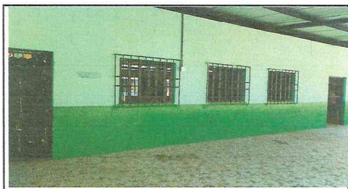
FOTO 4: Sustrucción de 18 balcones
