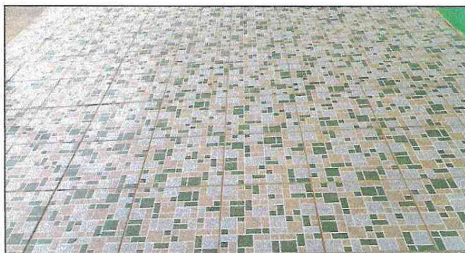
FOTO 3: Sustrucción de piso para corredor y cocina
