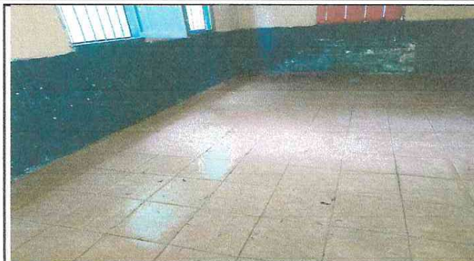
FOTO 2: Sustrucción de piso en 5 aulas modulo 1
