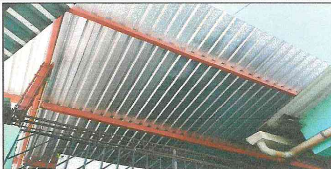
FOTO 1: Sustrucción de lámina en 4 aulas y cocina
