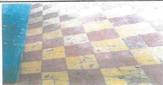
Foto 2: sustitución de piso para corredor y 5 aulas del modulo 1
