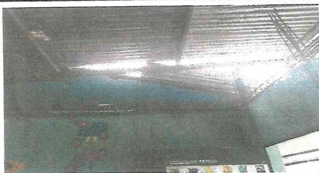
Foto 1: Sustitución de lámina, por lamina troquelada aluzinc calibre 26 para 4 aulas del módulo 3 y cocina.
