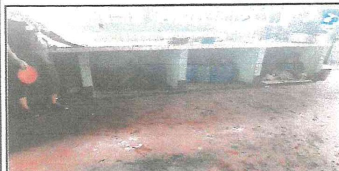
Foto 5: Fabricación e Instalación de Puertas para gabinetes de cocina.
