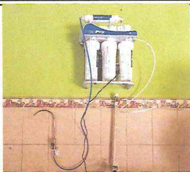
Foto 1: Instalación de filtro de agua Osmosis
