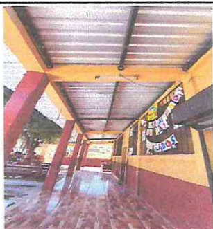
Foto 5: Sustitución de Lamina, por lamina troquelada calibre 26
