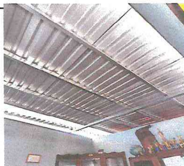
Foto 6: Sustitución de estructura de soporte y sustitución de lamina acanalada, por lamina troquelada calibre 26,
