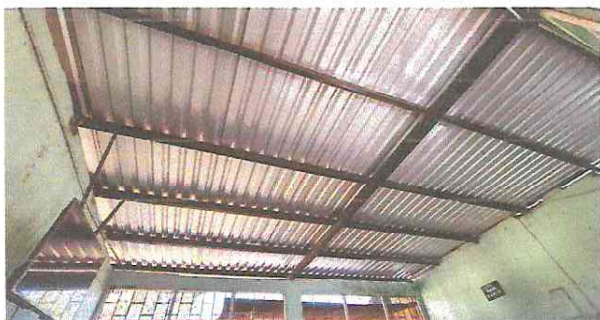
Foto 3: Sustitución de Lamina, por lamina troquelada calibre 26
