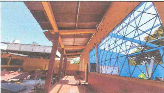
Foto 5: Sustrucción de Lamina, por lamina troquelada calibre 26
