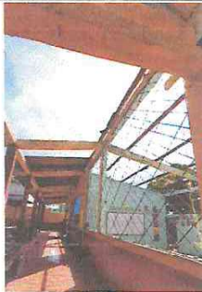
Foto 3: Sustrucción de Lamina, por lamina troquelada calibre 26
