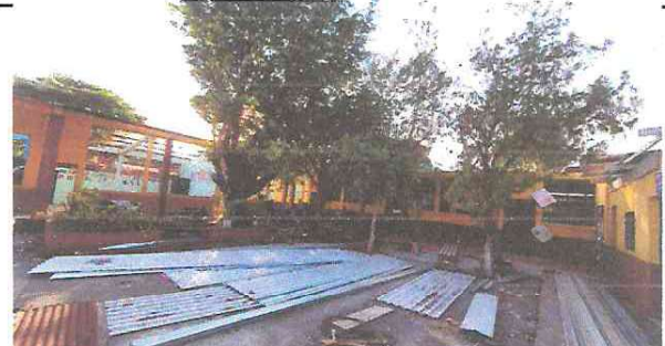
Foto 6: Sustrucción de estructura de soporte y sustitucion de lamina acanalada, por lamina troquelada calibre 26,
