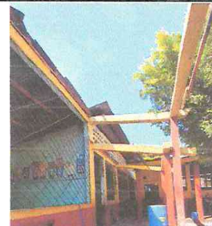
Foto 4: Sustrucción de estructura de soporte de madera, por metal
