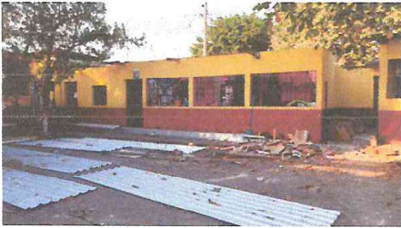
Foto 1: Sustrucción de Lamina, por lamina troquelada calibre 26
