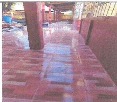
Foto 12: Sustrucción de Piso Cerámico Antideslizante
