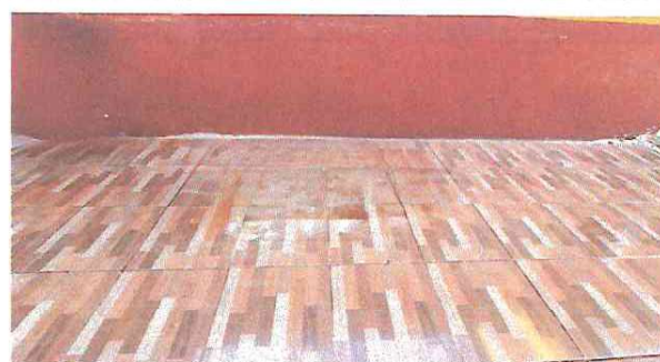
Foto 4: Sustitución de Piso Cerámico Antideslizante en escenario.
