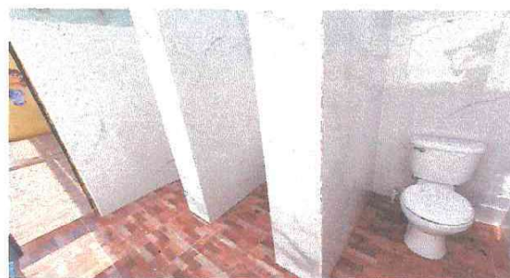
Foto 6: Sustitución de Inodoro, sustitución de piso cerámico y suministro Porcelanato en pared.
