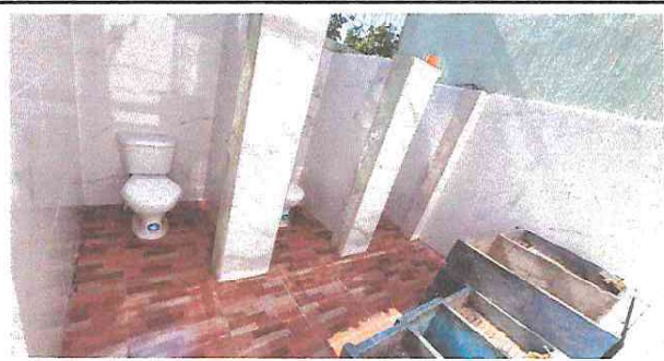
Foto 7: Sustrucción de tubería de agua potable y drenaje en servicio sanitario.
