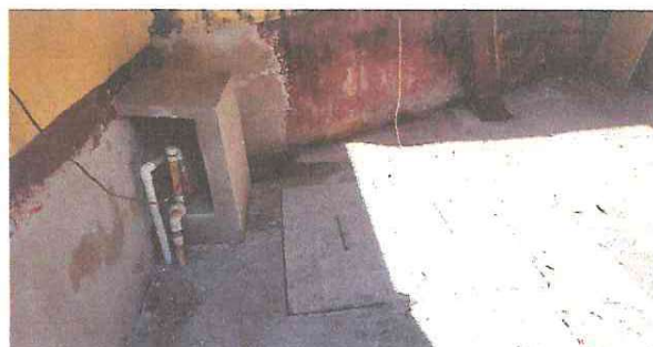
Foto 8: Sustrucción de línea principal de agua potable y modificación de muro perimetral de pozo, así como cubierta de concreto para bomba de agua.
