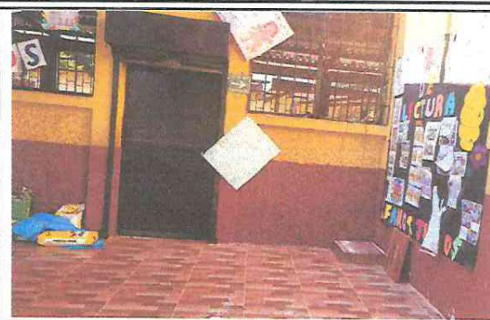
Foto 2: Sustitución de Piso Cerámico Antideslizante en corredores
