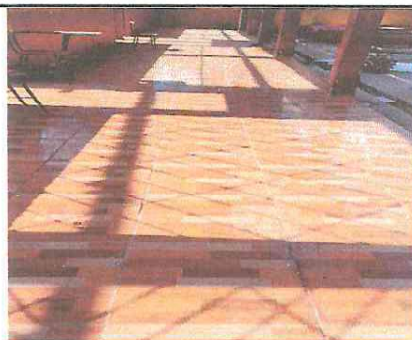
Foto 10: Sustrucción de Piso Cerámico Antideslizante
