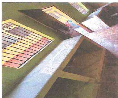
Foto 9: Suministro de mesón de cocina con azulejo
