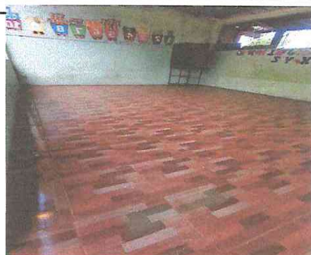
Foto 3: Sustitución de Piso Cerámico Antideslizante en 4 aulas
