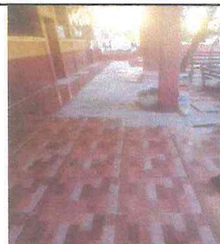
Foto 10: Sustitución de Piso Cerámico Antideslizante
