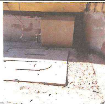
Foto 8: Sustitución de línea principal de agua potable y modificación de muro perimetral de pozo, así como cubierta de concreto para bomba de agua.
