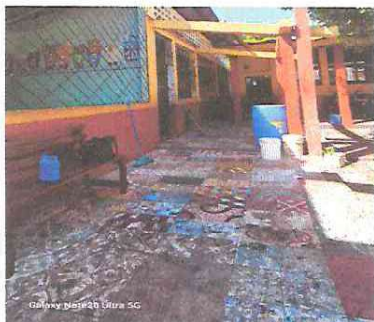
Foto 3: Sustitución de Piso Ceramico Antideslizante en 4 aulas
