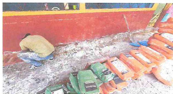
Foto 2: Sustitución de Piso Ceramico Antideslizante en corredores
