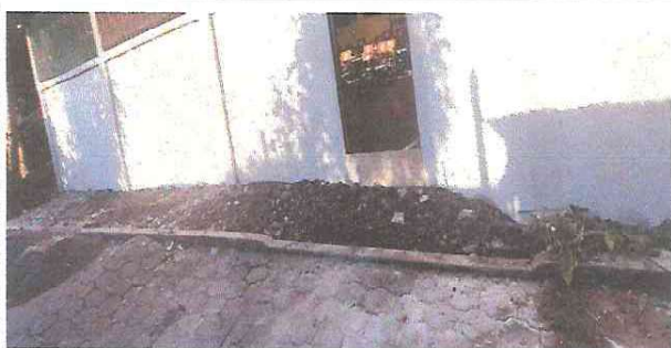
Foto 5: Mejoramiento de Banqueta de concreto
