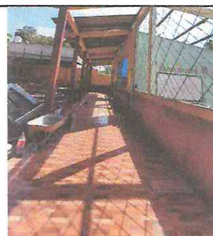
Foto 12: Sustitución de Piso Cerámico Antideslizante
