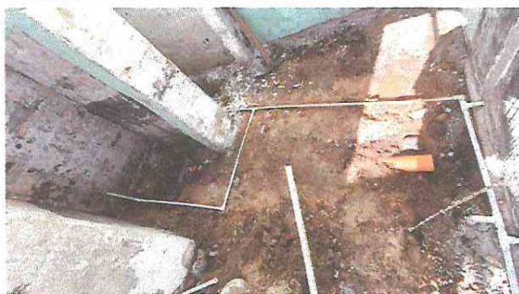
Foto 7: Sustitución de tubería de agua potable y drenaje en servicio sanitario.
