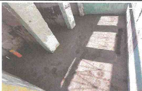
Foto 6: Sustitución de Inodoro, suministro de puertas, sustitución de piso ceramico y suministro Porcelanato en pared
