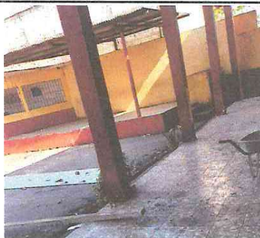
Foto 4: Sustitución de Piso Ceramico Antideslizante en escenario.
