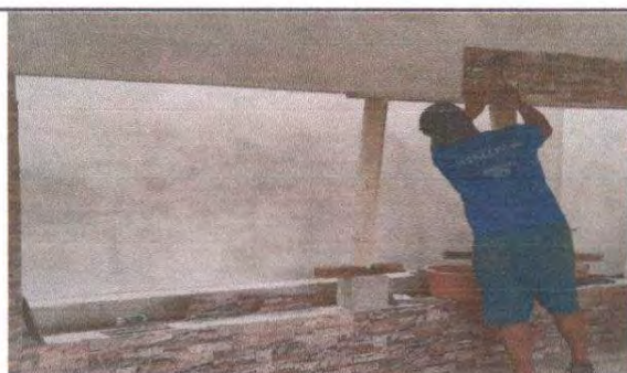
Foto 5: colocación de fachaleta de polietileno
