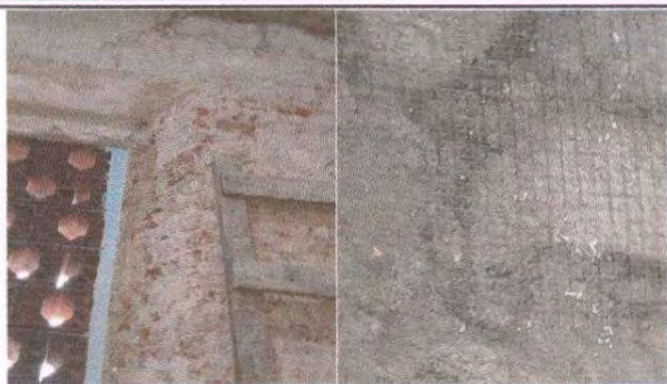
Foto 1: Reparación y refuerzo de dirección
