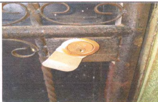
Foto 3: Sustitución de chapa puerta de rejas
