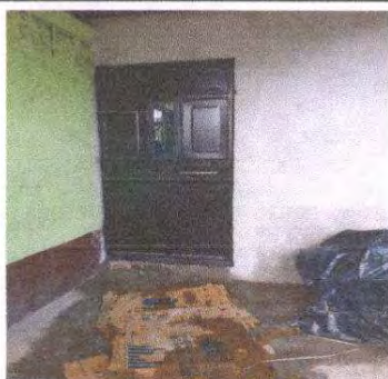
Foto 1: Sustitución de Puerta de metal
