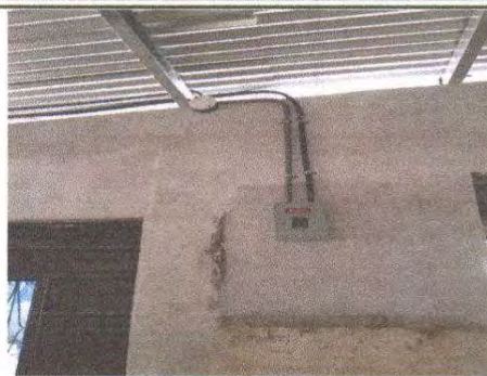
Foto 2: Reparación del sistema eléctrico cocina
