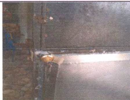
Foto 2: Reparación de puerta y cambio de chapa de cocina
