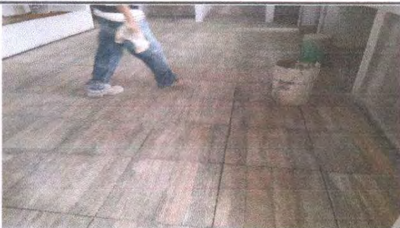
Foto 5: Sustitución de piso por piso cerámico
