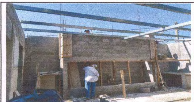
Foto 5: Sustitución de polietileno con chimenea
