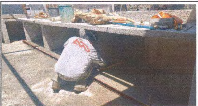
Foto 3: Sustitución de gabinete de concreto
