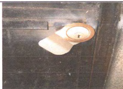
Foto 4: sustitución de chapa puerta de dirección
