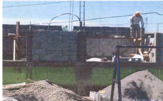
Foto 2: Levantado de pared de block repello y cernido
