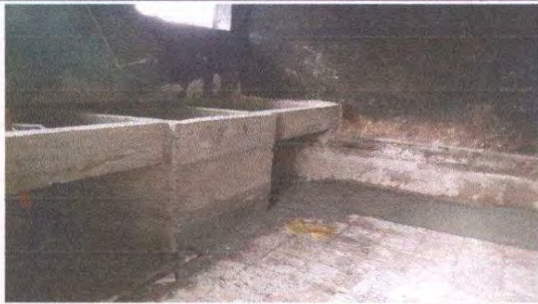
Foto 1: Sustitución de pila de concreto con dos lavaderos
