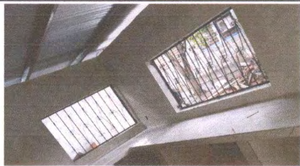
Foto 4: Sustitución de balcones de estructura metálica
