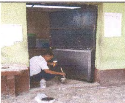
Foto 4: Mantenimiento de puerta de cocina
