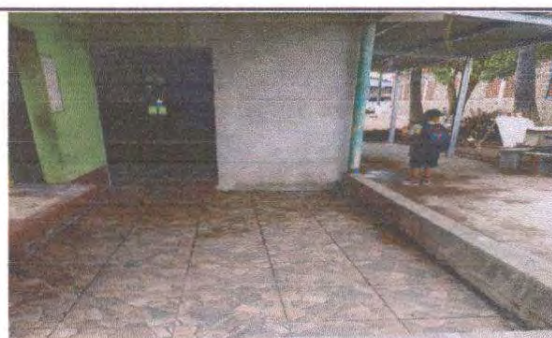
Foto 6: Sustitución de piso cerámico de corredor de pila
