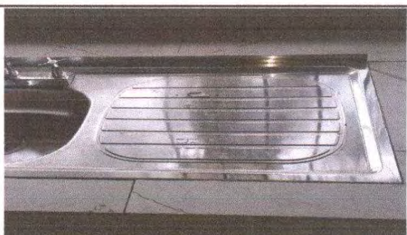
Foto 6: Sustitución de lavatrastos
