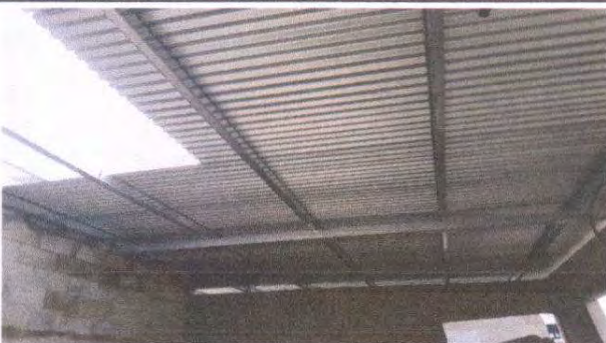
Foto 3: Sustitución de cubierta por lámina calibre 26
