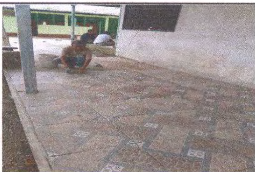
Foto 5: Losa de patio y piso para exterior
