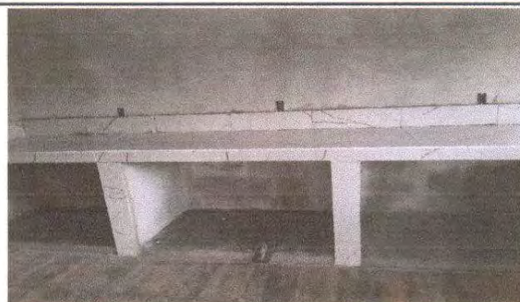
Foto 4: Sustitución de azulejo en gabinete de concreto
