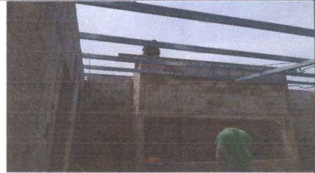
Foto 2: Sustitución de soporte por metal
