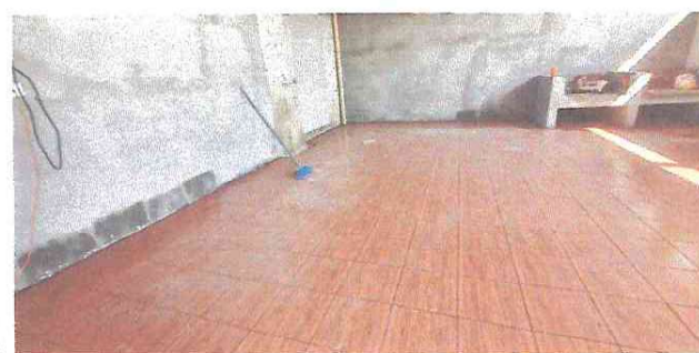
Foto 6: Piso ceramico colocado en la cocina y elaboración de un poletón.
