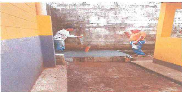
Foto 5: Relleno patio trasero y base para colocacion de pila
