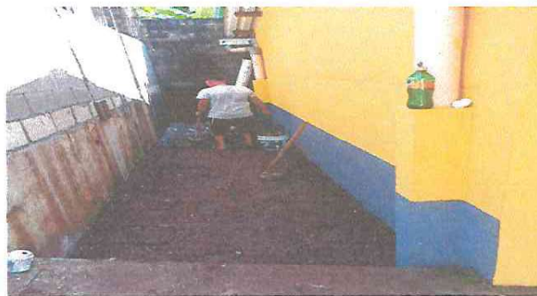
Foto 4: Relleno de patio trasero del salon.
