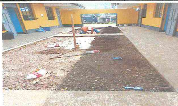
Foto 2: Torta de cemento y colocacion de tubo para salidad de agua
