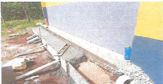
Foto 3: Relleno de banqueta.
