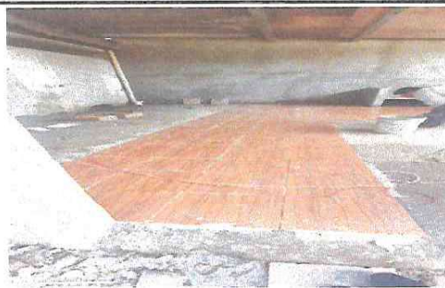
Foto 6: Colocación de piso ceramico en la cocina
