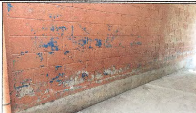
Foto 8: Estado actual de la pintura en muros del establecimiento, debido al desgaste de esta misma se solicita la aplicación de pintura.
