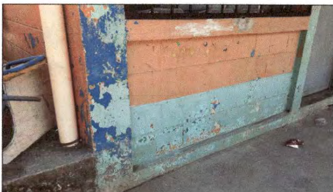
Foto 9: Estado actual de la pintura en muros del establecimiento, debido al desgaste de esta misma se solicita la aplicación de pintura.
