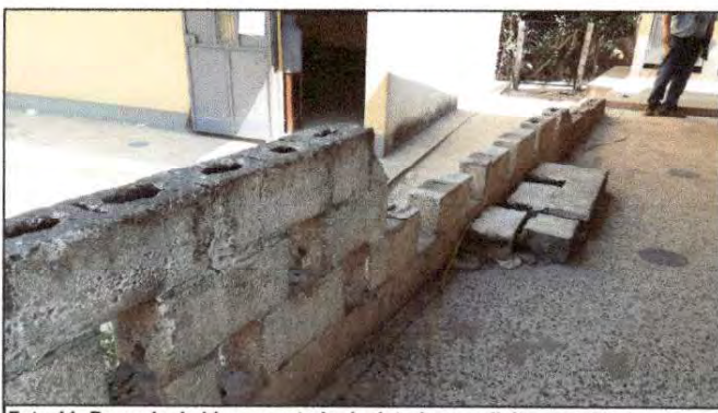
Foto 11: Baranda de bloc en estado de deterioro, solicitan cambiarla por baranda metálica por seguridad de los niños.
