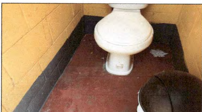
Foto 6: Estado actual de los servicios sanitarios, solicitan el mantenimiento y reparación de tuberías, ya que algunos inodoros se encuentran inhabilitados.
