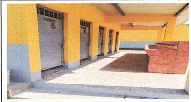
Foto 5: Puertas de metal en sanitarios.
