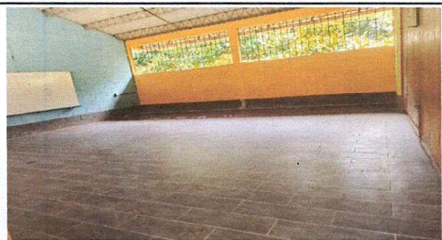
Foto7: Módulo I aula, sustitución de piso.
