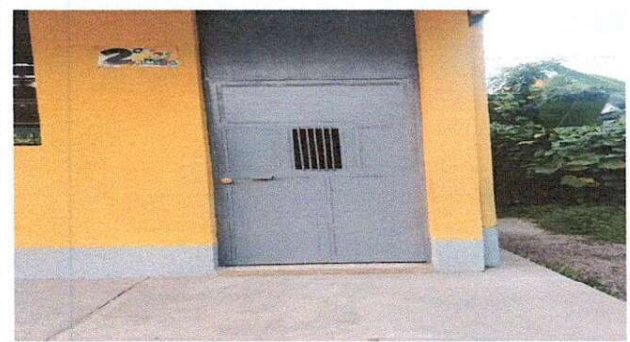
Foto 9: Puerta de metal.
