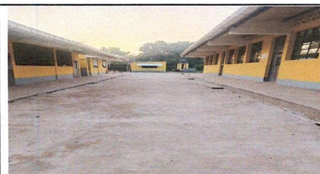
Foto 11: Patio: fundición de plancha de concreto en área de patio.
