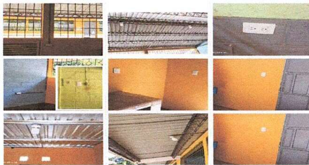
Foto 10: Reparación del sistema eléctrico.
