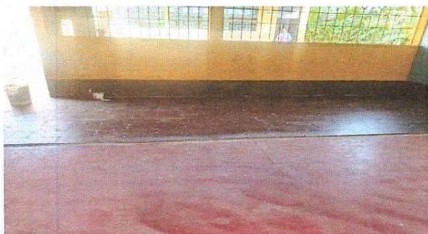
Foto 7: Módulo I aula, sustitución de piso.
