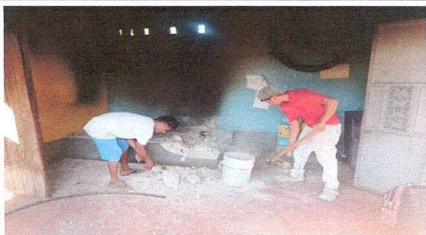
Foto1: Reparación de cocina.
