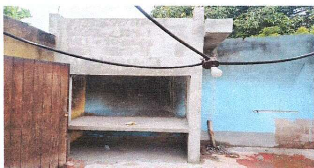
Foto 10: Reparación del sistema eléctrico.
