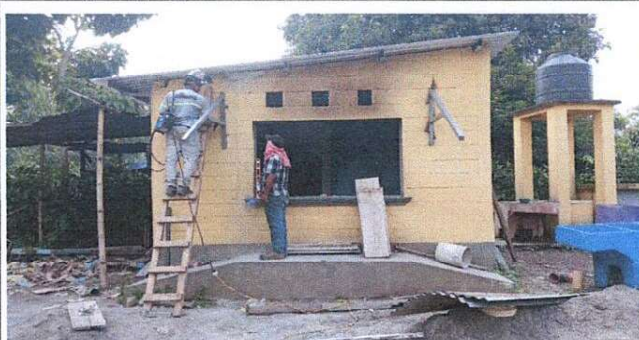
Foto 2: Estructura de techo.
