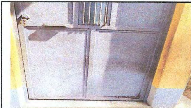
Foto 13: Sustitución puerta de metal
