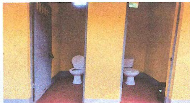
Foto 9: Sustitución de inodoro
