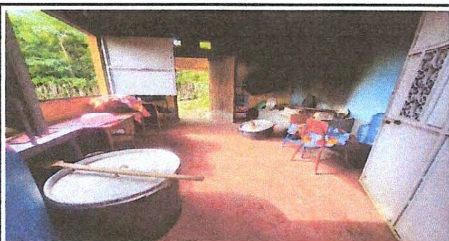
Foto 5: pintura en muros interior y exterior
