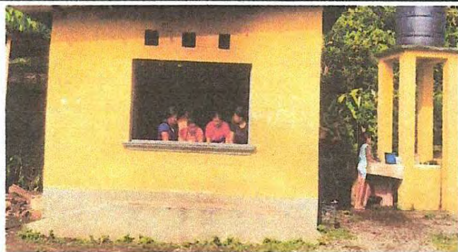
Foto 1: Instalación de Estructura de Lamina en ventana
