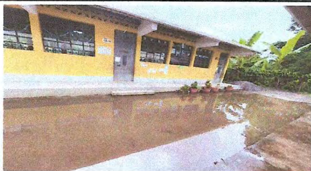
Foto 17: Fundición de plancha de concreto frontal
