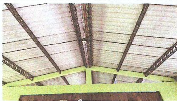
Foto 16: Reparación de cableado eléctrico
