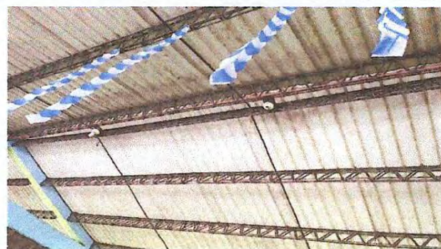
Foto 14: Sustitución de Lámparas
