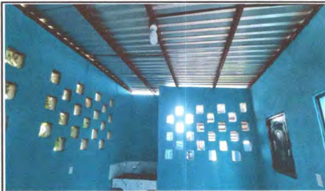
Foto 2: ESTRUCTURA DE TECHO, Se instaló una estructura metálica en el techo de la cocina para reforzar su seguridad y durabilidad.
