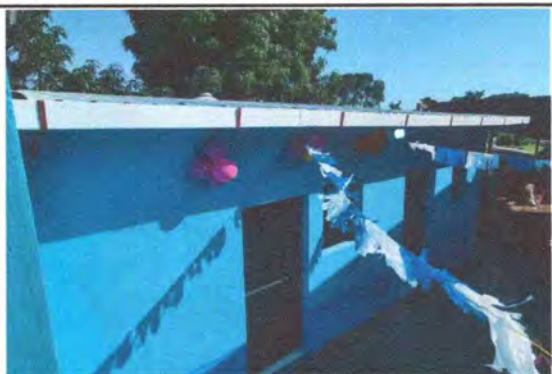
Foto 1: CUBIERTA DE LAMINA, Se cambio el techo para mayor resistencia y durabilidad.
