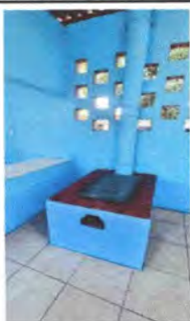
Foto 11: REPARACIÓN DE COCINA; Se llevará a cabo la reparación de la estufa de leña, incorporando una plancha y chimenea para mejorar su rendimiento y seguridad.
