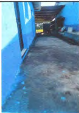
Foto 7. CUBIERTA DE CONCRETO. Se coloca una maqueta para evitar acumulación de agua y la humedad en la cocina.
