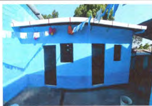
Foto 10. MANO DE OBRA ESPECIALIZA. Se manda a fabricar Puertas, Ventana, Estructura, portante, láminas e instalaciones eléctricas y desinstalación de estructura y lámina.
