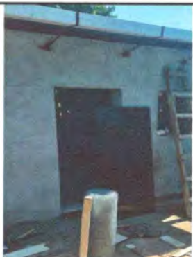
Foto 3: PUERTA, Se reemplazo la puerta de madera a metal.
