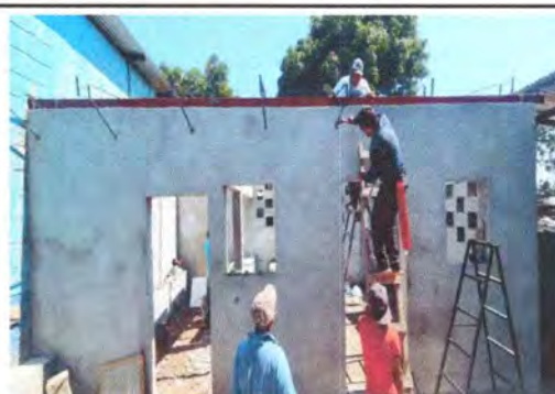
Foto 10: MANO DE OBRA ESPECIALIZADA, Se mandó a fabricar Puerta, Ventana, Estructura Portante, Láminas e instalaciones eléctricas y desinstalación de estructura y lámina.
