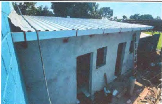
Foto 1: CUBIERTA DE LAMINA, Se procedio a colocar el nuevo techado de la cocina.
