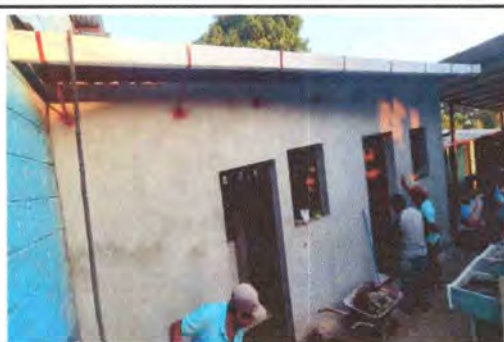
Foto 12: REPARACIÓN DE REPELLO Y CERNIDO DE PAREDES, Se realizó la preparación de la pared para la aplicación de repello y cernido para impermeabilizar.
