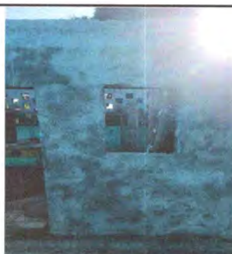
Foto 4: VENTANA. Se quito la ventana para cambiarla por metal.
