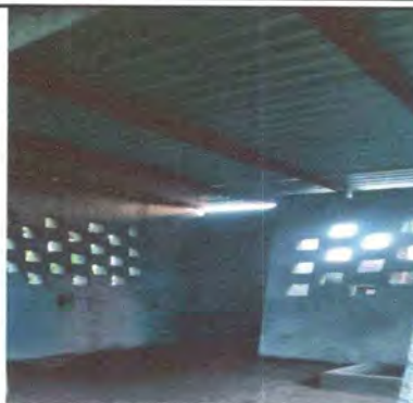
Foto 2: ESTRUCTURA DE TECHO, Se coloco la estructura de metal para que mayor durabilidad al techo de la cocina.
