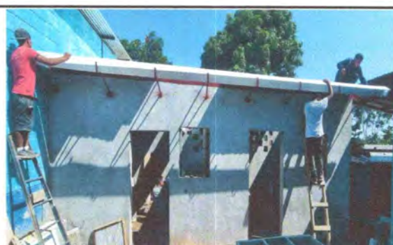
Foto 6: CANALES Y BAJADAS DE AGUA PLUVIAL, Se coloco el canal para el agua pluvial.
