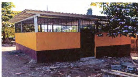
Foto 4: Cocina sustitución de estructura de soporte de madera por metal
