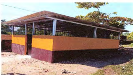
Foto 5: Cocina levantado de 4 hiladas de block
