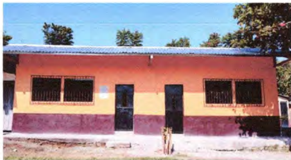
Foto 3: Aulas levantado de 3 hiladas de block
