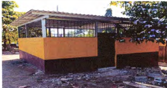
Foto 6: Cocina sustitución de lámina por lámina troquelada aluzinc calibre 26
