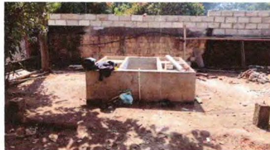
Foto 12: Galera sustrución de postes de madera por metal
