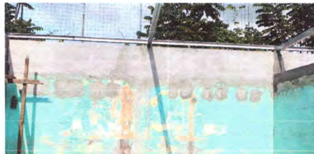
Foto 2: Aulas sustitución de estructura de soporte de madera por metal
