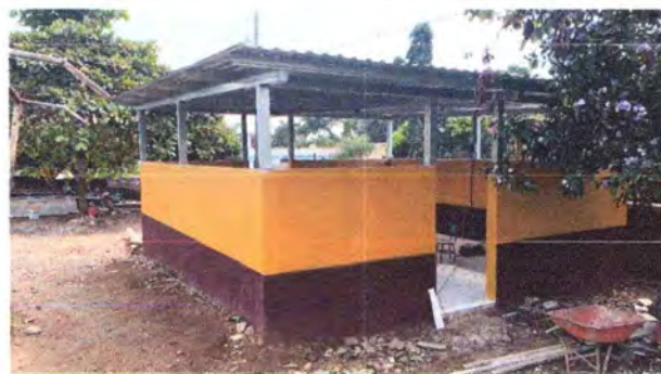
Foto 4: Cocina sustitución de estructura de soporte de madera por metal
