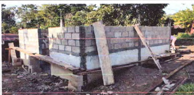
Foto 5: Cocina levantado de 4 hiladas de block
