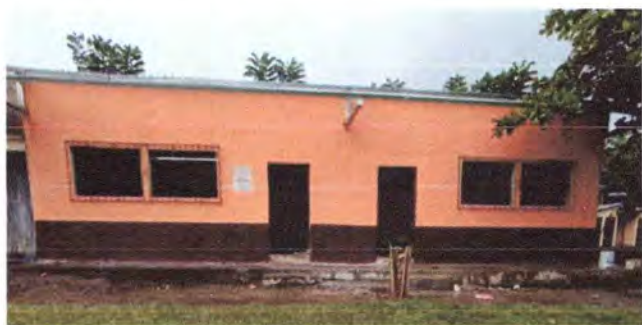
Foto 1: Aulas sustitución de lámina por lámina troquelada aluzinc calibre 26
