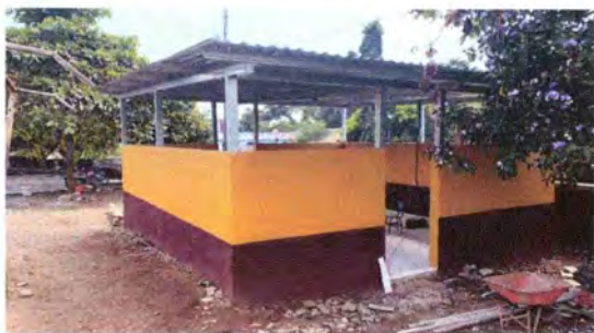
Foto 7: Sustrución de puertas de lámina por puertas de metal
