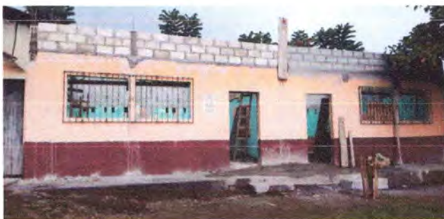
Foto 3: Aulas levantado de 3 hiladas de block
