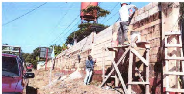
Foto 11: Muro perimetral reparación, cernido y pintado
