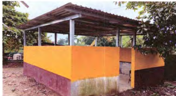
Foto 10: Cocina pintura en muro exterior
