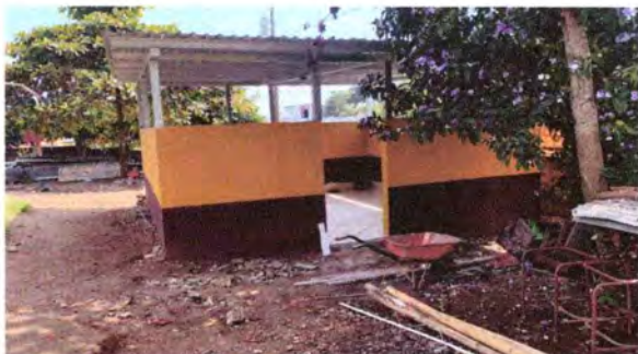
Foto 9: Cocina sustrución de malla por balcones
