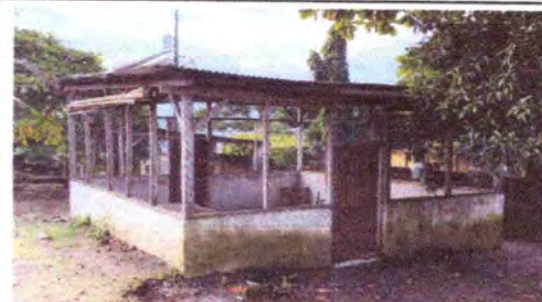
Foto 6: Cocina sustitución de lámina por lámina troquelada aluzinc calibre 26
