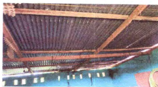
Foto 2: Aulas sustitución de estructura de soporte de madera por metal
