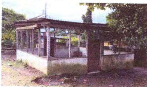
Foto 7: Cocina, sustitución de puertas de lámina por puertas de metal
