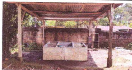
Foto 12: Pileta de cocina sustitución de estructura de madera por metal
