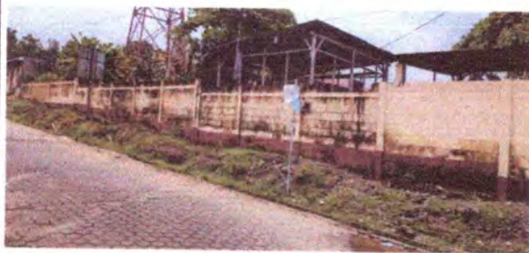
Foto 11: Muro perimetral reparación, cernido y pintado en el exterior del centro educativo
