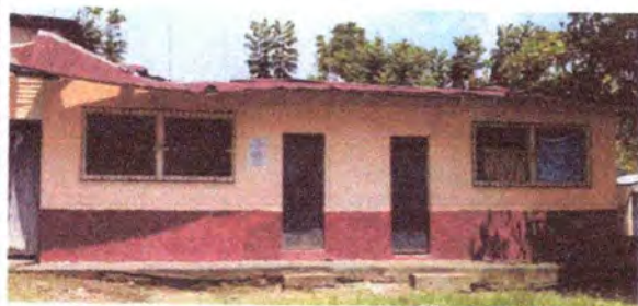
Foto 1: Aulas sustitución de lámina por lámina troquelada aluzinc calibre 26
