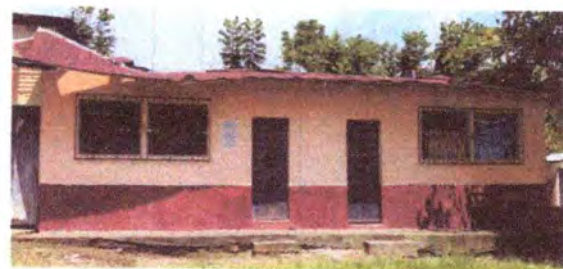
Foto 3: Aulas levantado de 3 hiladas de block
