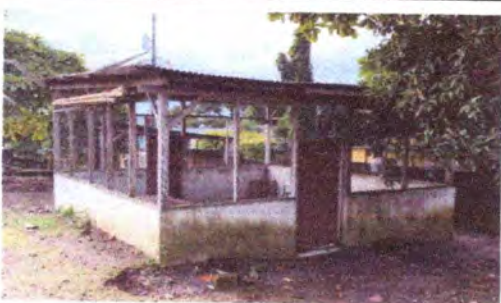
Foto 9: Cocina sustitución de malla por balcones
