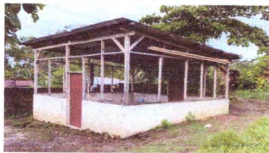
Foto 5: Cocina levantado de 3 hiladas de block
