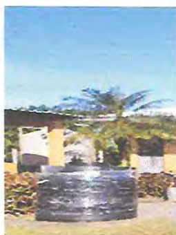
Foto 9: Sustitución de depósito de agua por uno de 1700 litros (Incluye accesorios).
