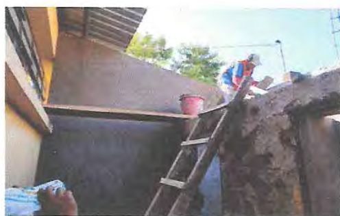
Foto 11: Cerramiento de muro con levantado de block en muro perimetral adjunto al servicio sanitario y Mantenimiento a puertas 0.75 x 1.80 M (Lijado, cepillado, aplicación de pintura).
