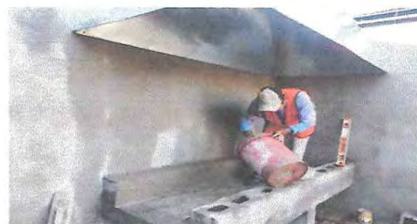
Foto 6: Sustitución de estufa rural (Completa chimenea).
