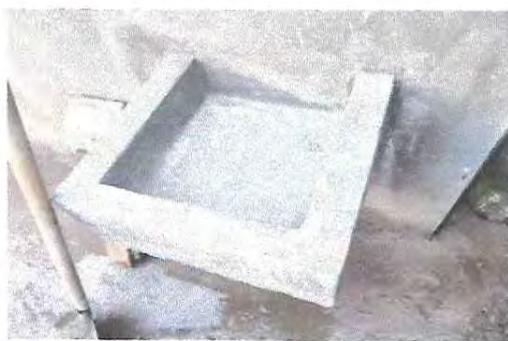
Foto 17: Construcción de lavamanos en el área de cocina.
