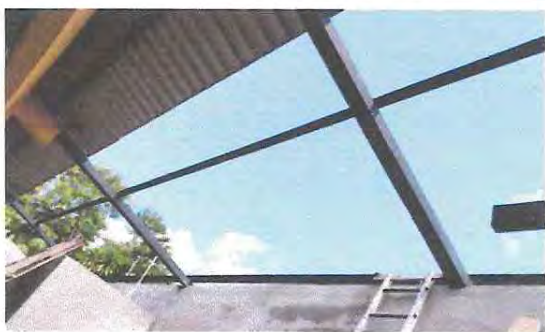
Foto 13: Sustrucción de lamina por lámina troquelada calibre 26.
