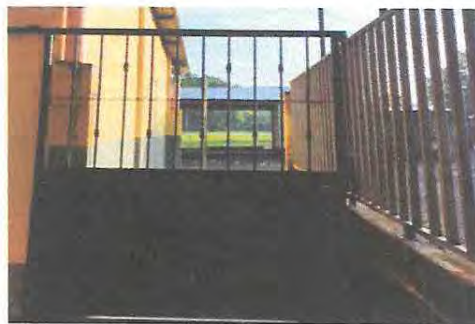
Foto 16: Sustrucción de puerta (reja) por puerta con lámina lisa.
