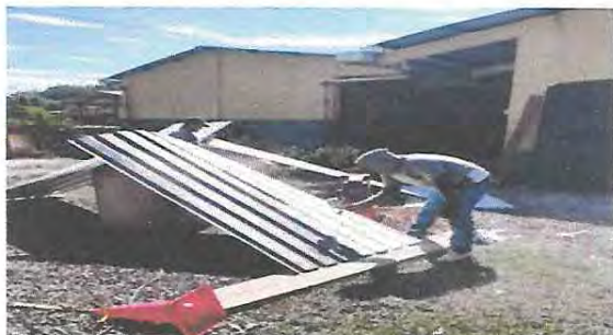
Foto 7: Mantenimiento a estructura de soporte de metal de la cocina (Lijado y pintura de costaneras y láminas).
