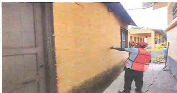
Foto1: Sustitución de puerta de madera por metal, repello, cernido en cocina.
