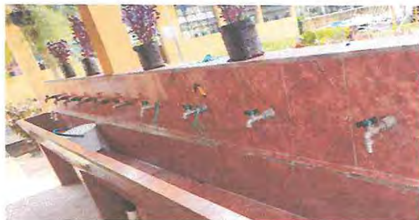
Foto 8: Sustitución de chorros.
