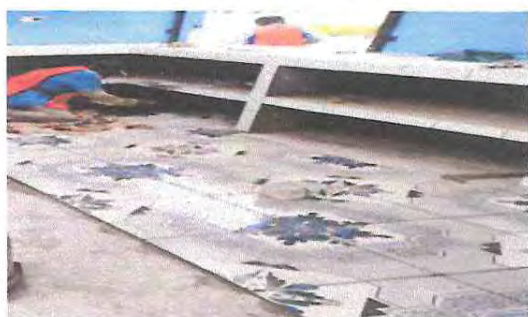
Foto 5: Sustitución de piso de concreto alisado por piso cerámico e instalación de azulejo en muebles de cocina.
