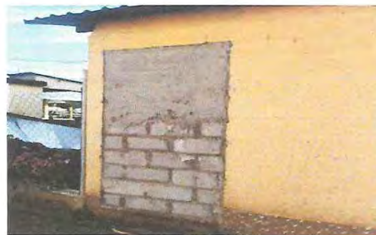
Foto 2: Cerramiento en muro con levantado de block y en cocina.
