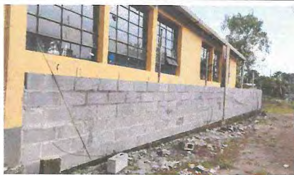
Foto 18: Levantado de muro perimetral.
