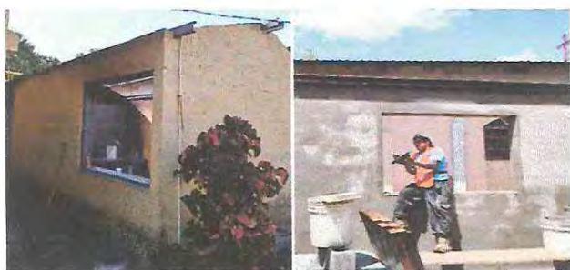
Foto 3: Sustitución de ventanas de madera por metal.
