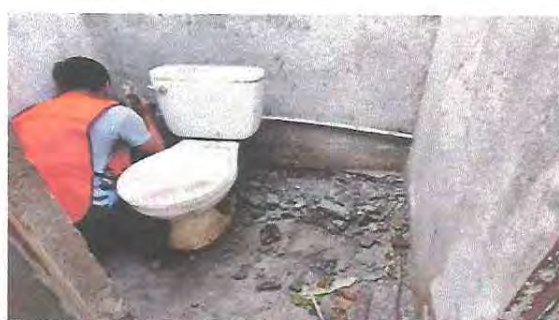
Foto 12: Sustitución de migitorio, de accesorios de inodoro (Contrallave, manguera de abasto, y accesorios de tanque, sustitución de tapaderas, sustitución de mezcladora para ducha). Pintura de muros interiores y exteriores de muro perimetral y baños.
