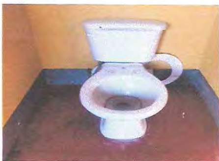
Foto 15: Sustrucción de accesorios de inodoro (Contrallave, manguera de abasto y accesorios de tanque).
