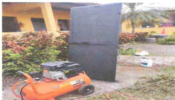
Foto 14: Mantenimiento de puertas, (Lijado, cepillado aplicación de pintura).
