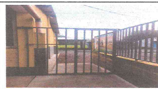
Foto 6: Sustitución de puerta de metal.
