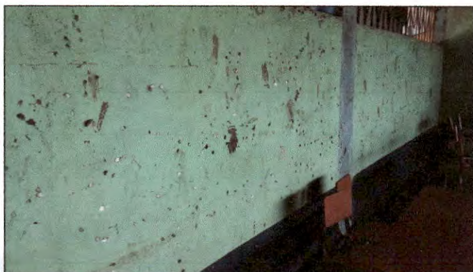
Foto 9: Estado actual de la pintura en muros del establecimiento, solicitan la aplicación de pintura debido al desgaste en el que se encuentra.
