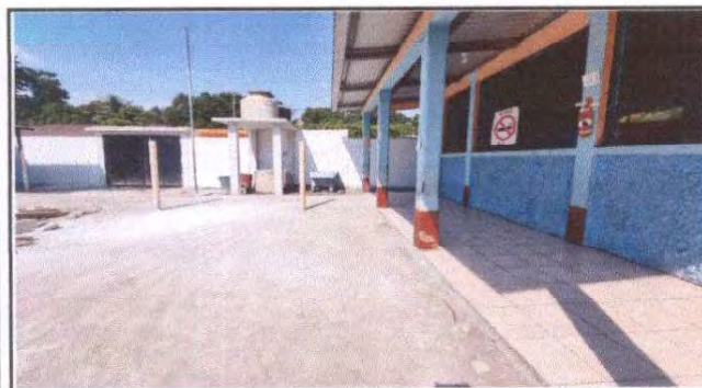
Sustitución de torta de cemento por piso cerámico en corredor.
