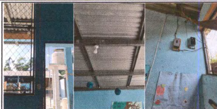
Reparación de Sistema Eléctrico.
