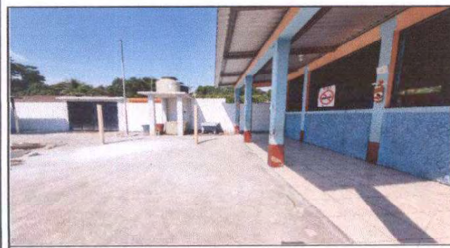
Repello en muro de pared
