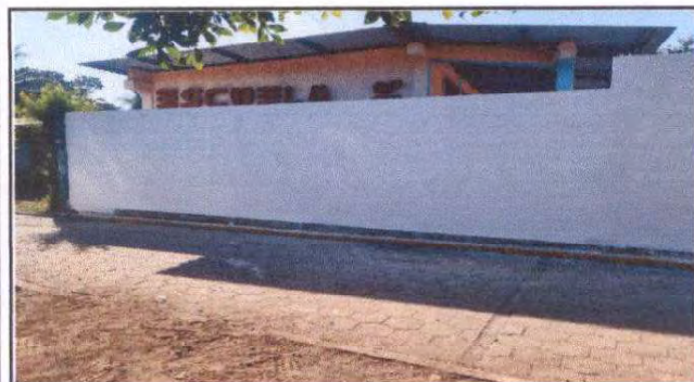
Repello en muro de pared
