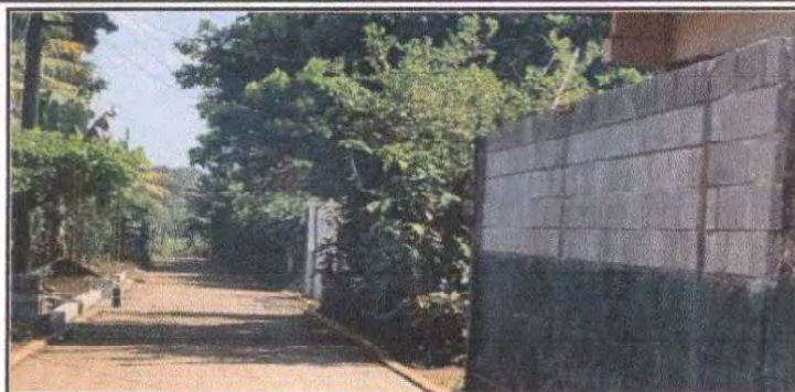
Sustitución de muro perimetral de balcon por block
