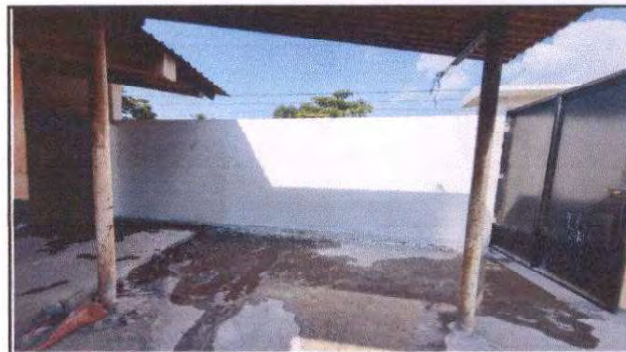
Repello en muro de pared atrás
