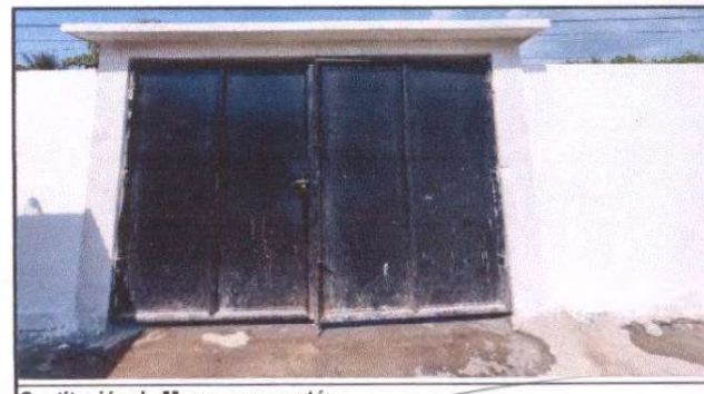
Sustitución de Muros para portón.
