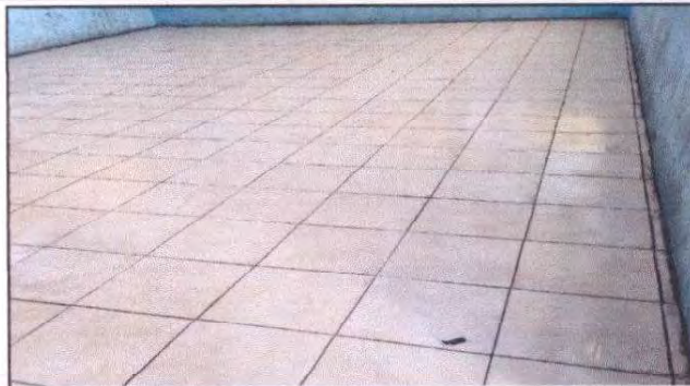
Sustitución de torta de cemento por piso cerámico en aulas
