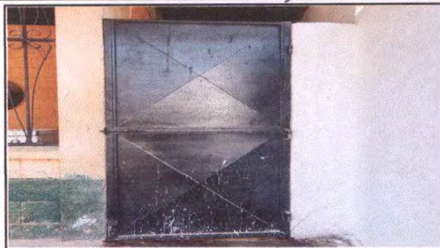
Instalación de puerta en cocina
