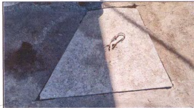
Reparación de caja de drenaje
