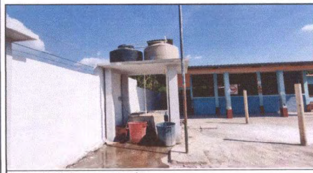
Sustitución de base para rotoplas.
