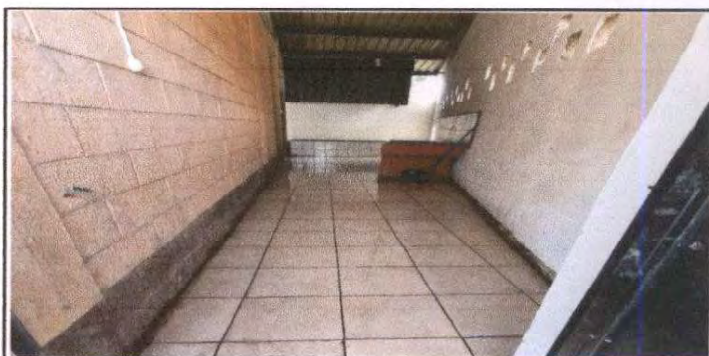
Sustitución de torta de cemento a piso cerámico en cocina.
