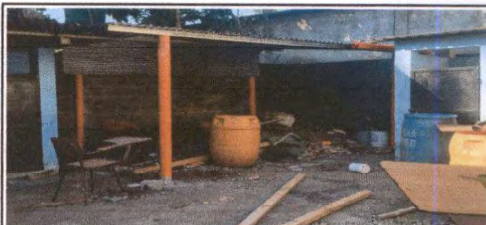
suministro de lamina y parales para Galera
