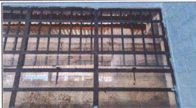
Sustitución de ventanas de vidrio por balcon de metal.
