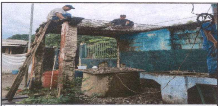
Sustitución de base para rotoplas.
