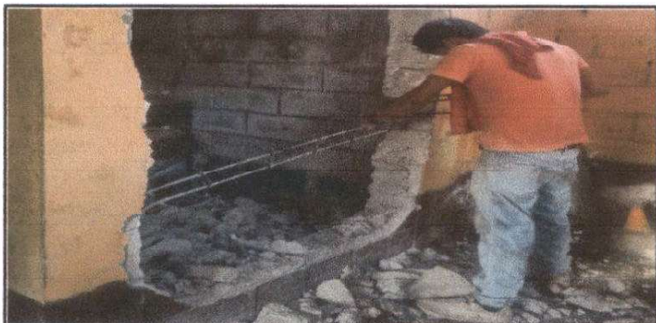
Ampliación de pared para cocina
