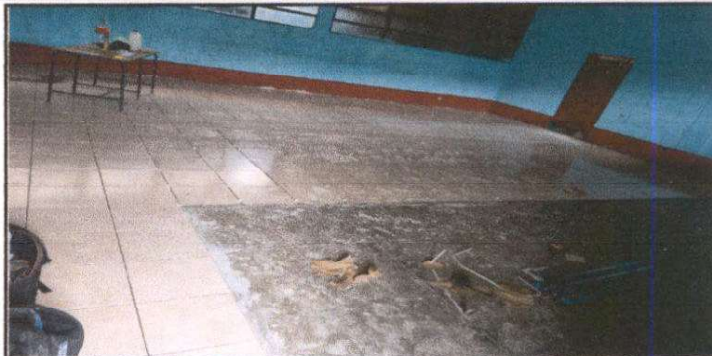
Sustitución de torta de cemento por piso cerámico en aulas
