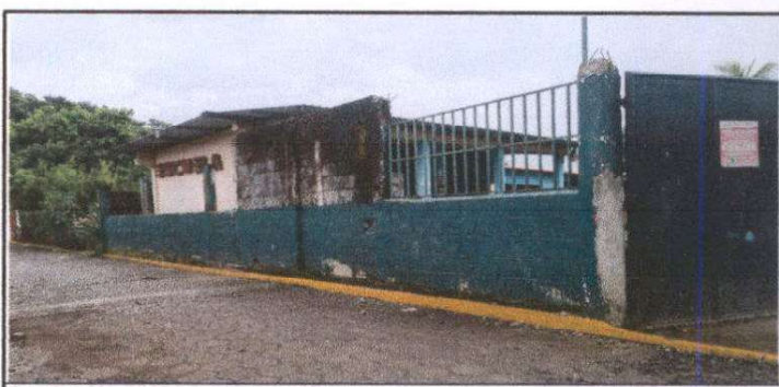
Sustitución de Muros para portón.
