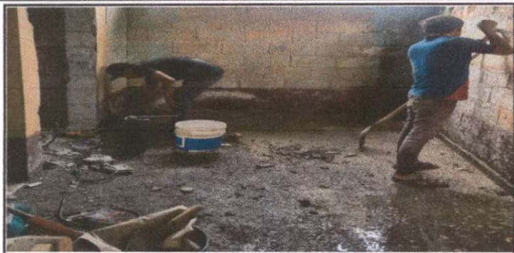
Sustitución de Torta de Cemento por piso cerámico en cocina.
