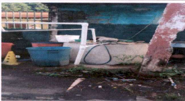
Foto 3: Sustitución de tubería de abastecimiento de agua
