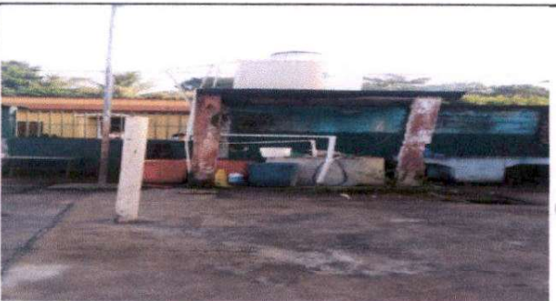
Foto 5: Sustitución de torre de concreto para instalación de depósito de agua
