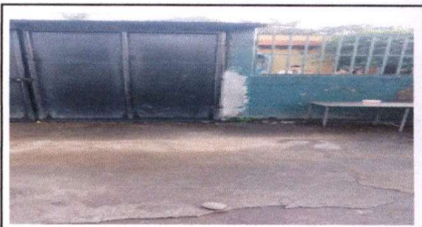
Foto 6: sustitución de balcón de metal por muro de block, sustitución de columnas de concreto armado para anclaje de portón de estructura metálica
