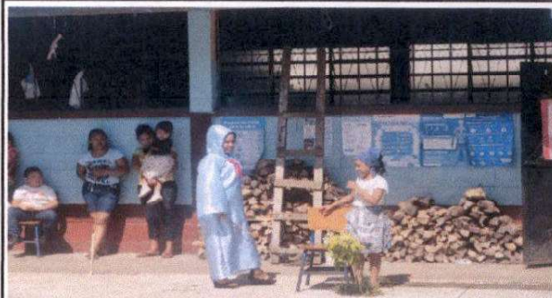
Foto 4: Sustitución de ventanas de vidrio y marcos de metal por balcón de metal y sustitución de vidrios quebrados
