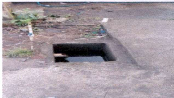
Foto 2: Reparación de caja de registro de drenajes
