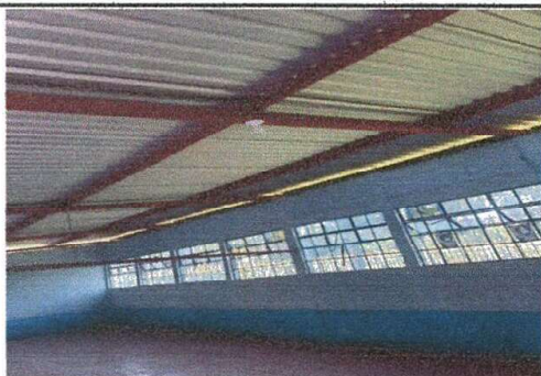
FOTO. MODULO I, Sustitución de torta de cemento por piso cerámico.
