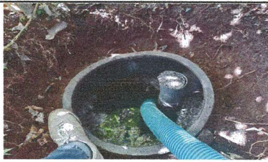
FOTO 6: MODULO IV, DRENAJE: Mantenimiento fosa septica.
