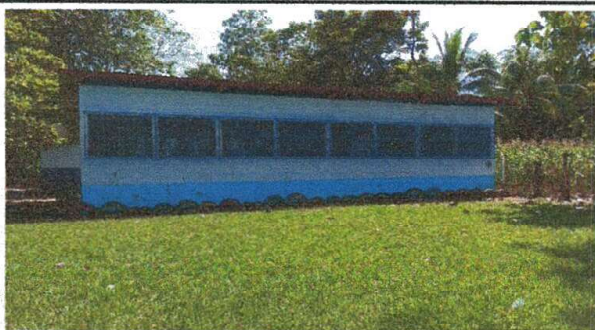
FOTO 5: MODULO I, Mantenimiento a balcones de metal.
