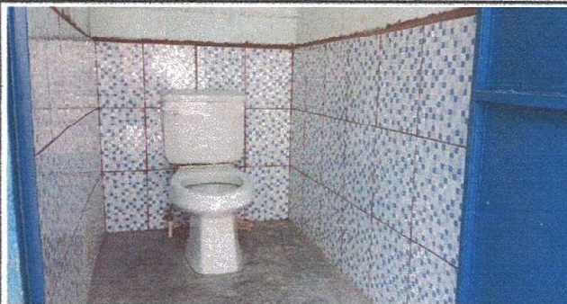
Foto 4: MODULO III, Servicios sanitarios y sus accesorios.
