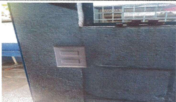
Foto 3: MODULO II, Reparación del sistema eléctrico.
